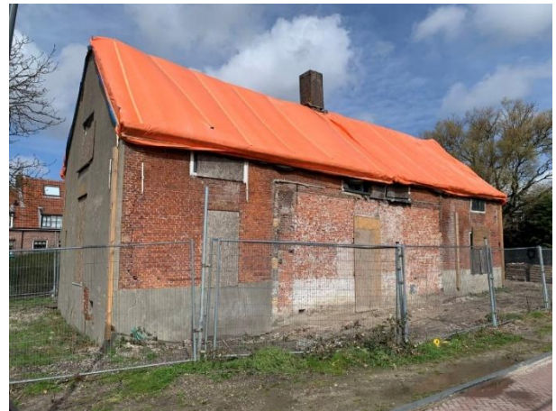
Figuur 2: Koetshuis Sion voor Restauratie
