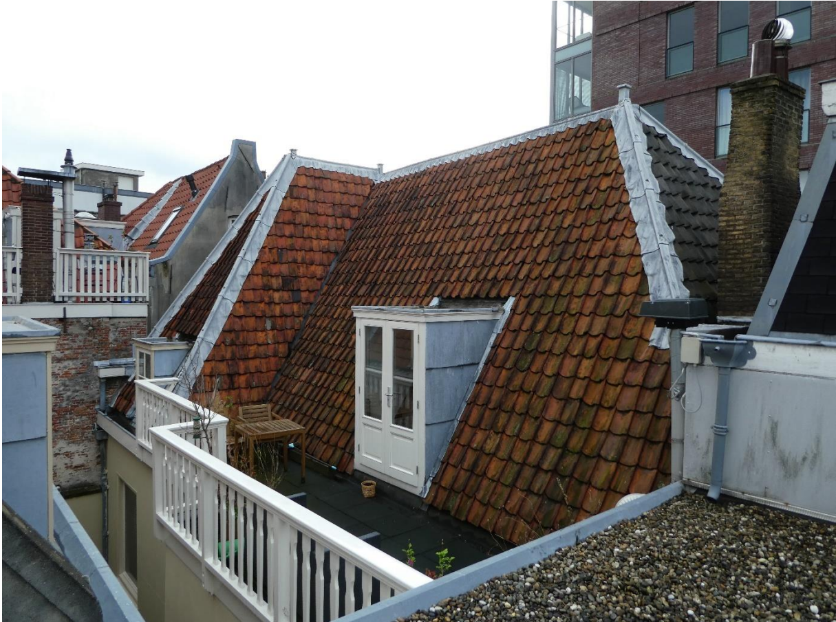
Overzicht van het L-vormige dak van het voorhuis, dat een plat dak aan de achterzijde omsluit. Dit platte dak is ingericht als een dakterras. Het rookkanaal van geeltjes dateert waarschijnlijk uit de 18 de eeuw.
