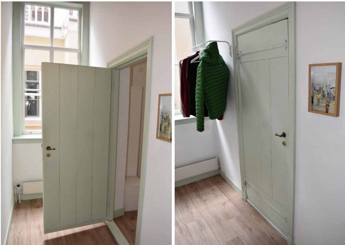
Het deurkozijn tussen de gang en de torenkamer op de eerste verdieping van het achterhuis, voorzien van een opgeklampte deur.
