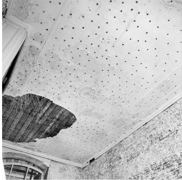
De linker voorkamer op de begane grond van het voorhuis in november 1983, foto's van G.J. Dukker (RCE beeldbank 246.236 en 246.437). Het stucplafond is doorgeschroefd.
