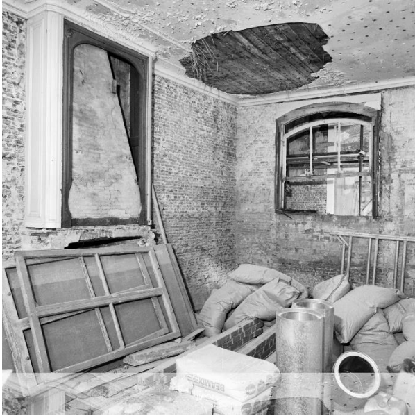
De linker voorkamer op de begane grond van het voorhuis in november 1983, foto's van G.J. Dukker (RCE beeldbank 246.236 en 246.437). Het stucplafond is doorgeschroefd.
