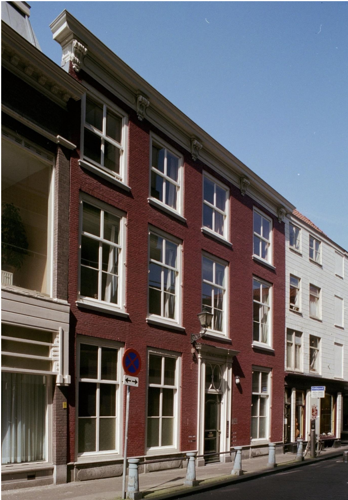
De voorgevel in 1998, foto van P. Lunenburg van de Dienst Stedelijke Ontwikkeling van 20 oktober 1998 (HGA beeldbank, nr. 7101-1). Langs de trottoirrand staat nog een reeks stoepaaltjes met ijzeren staven. In de gevels zijn nog hardstenen plaatjes aanwezig voor haakse aansluiting van ijzeren staven.
