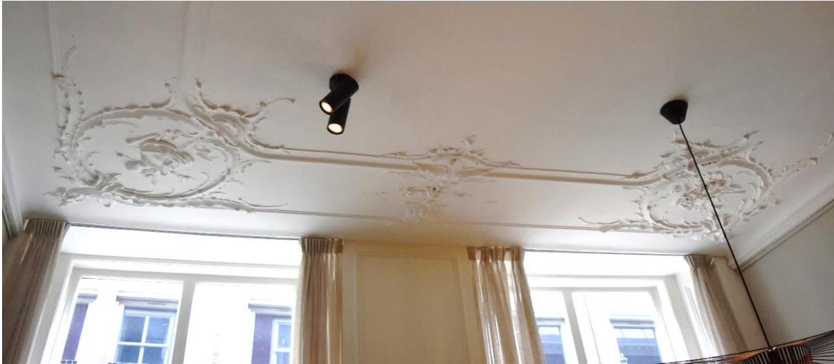
Het voorste deel van het stucplafond in de linker voorkamer op de begane grond van het voorhuis, voorzien van twee hoekstukken en een dubbele perklijst met Lodewijk-XV-motieven.
