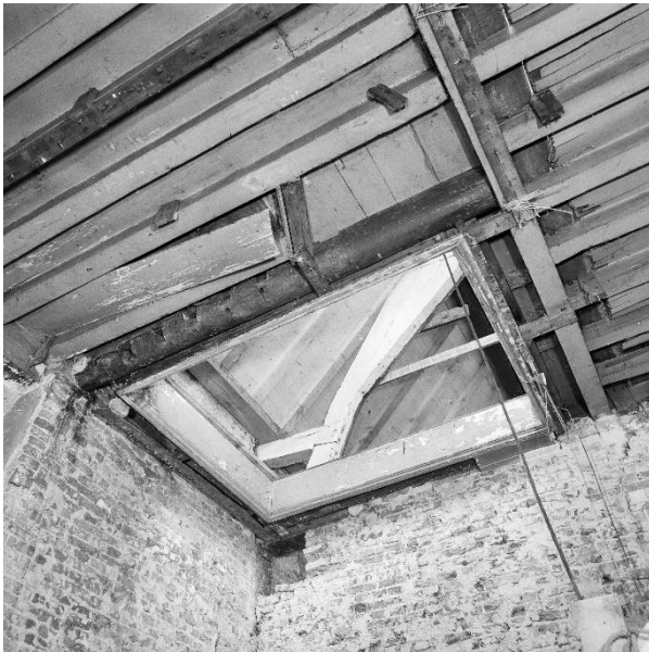
De raveling voor de zoldertrap in het achterhuis (links) en de kap van het achterhuis (rechts) in november 1983, foto's van G.J. Dukker (RCE beeldbank, 246.463 en 246.462).
