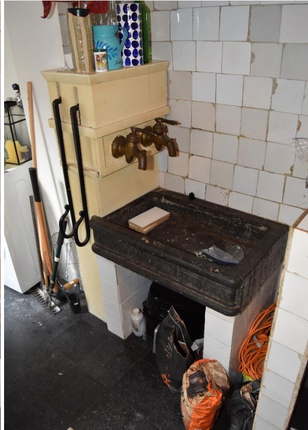
Links: overzicht van de keuken op de begane grond van het achterhuis, gezien naar de achtergevel. Rechts: de pomp naast de keukenschouw in de keuken. De pomp met zwingels komt van elders, het pomphuis is gereconstrueerd (1982-'84). De hardstenen gootsteen is origineel afkomstig uit het huis zelf.
