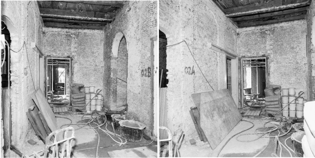
De hal op de begane grond van het voorhuis in november 1983, foto's van G.J. Dukker (RCE beeldbank 246.232 en 246.431). De (18 de -eeuwse) nissen zijn in bestaand metselwerk ingehakt.
