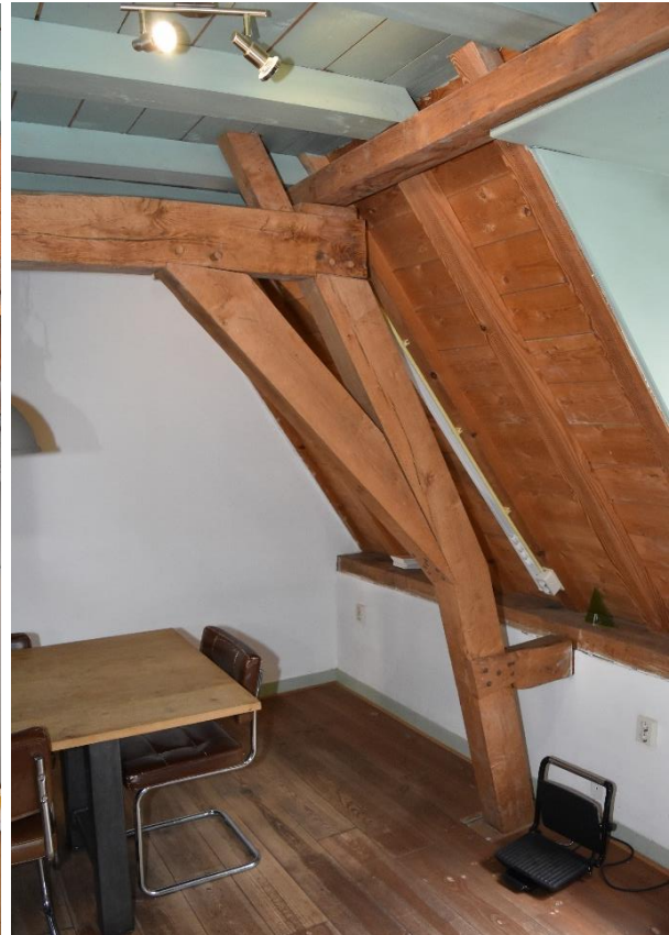
Eén van de halfspanten van de voorzolder van het achterhuis, geheel vernieuwd bij de restauratie van 1982-'84. Het zoldergebint is een langgerekte halfgebint met slechts één spantbeen.
