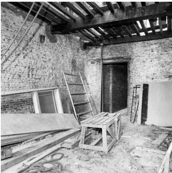
De linker achterkamer (links) en keuken (rechts) op de begane grond van het achterhuis in november 1983, foto's van G.J. Dukker (RCE beeldbank 246.449 en 246.450). Herkenbaar is dat alle vloeren en het spreidseel verwijderd zijn.
