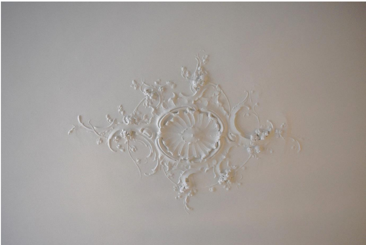
De middendecoratie van het stucplafond in de linkerkamer op de begane grond van het voorhuis, daterend uit het derde kwart van de 18 de eeuw.
