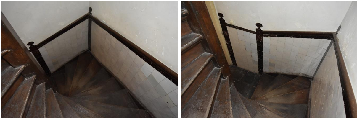
Overzichten van het trappenhuis in het achterhuis. De eikenhouten trap dateert vermoedelijk uit de 17 de eeuw. De lambrisering van 'witjes', voorzien van pilasterdecoraties en de buiklijst van gevlamde en schildpadtegels vermoedelijk uit de 19 de eeuw. De laatstgenoemde tegels stammen deels uit de 17 de en dele uit de 19 de eeuw.
