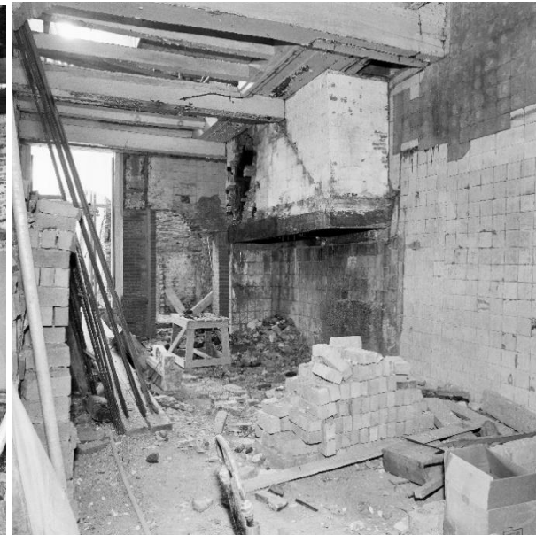
De linker achterkamer (links) en keuken (rechts) op de begane grond van het achterhuis in november 1983, foto's van G.J. Dukker (RCE beeldbank 246.449 en 246.450). Herkenbaar is dat alle vloeren en het spreidseel verwijderd zijn.
