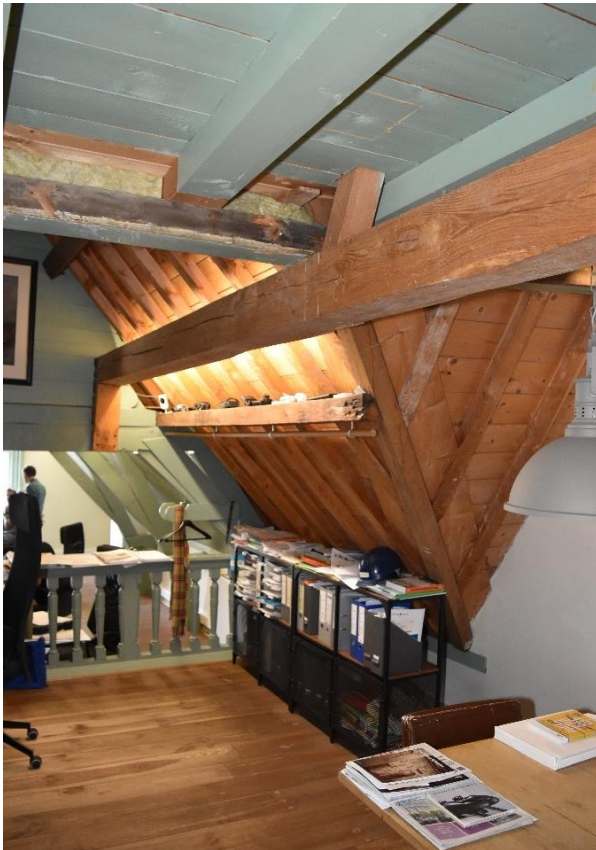
Eén van de halfspanten van de voorzolder van het achterhuis, geheel vernieuwd bij de restauratie van 1982-'84. Het zoldergebint is een langgerekte halfgebint met slechts één spantbeen.
