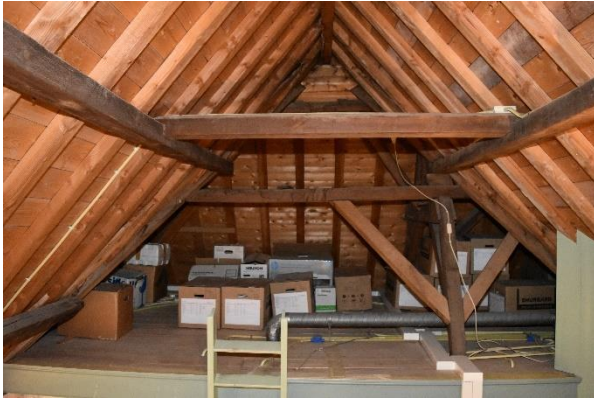
De vliering van de voorzolder, gezien vanaf de vliering van de achterzolder.
