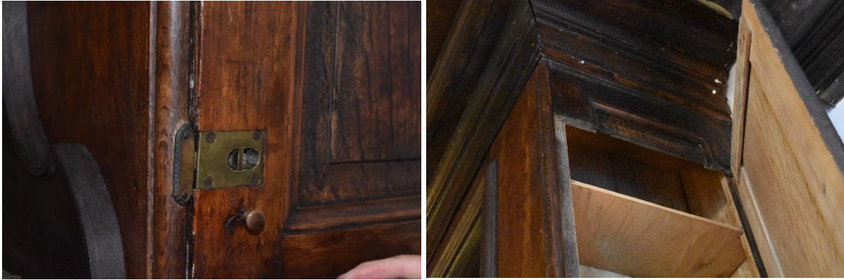
Eén van de kastjes in de zijwand van de boezembetimmering van de schouw in de linker achterkamer op de begane grond van het achterhuis.
