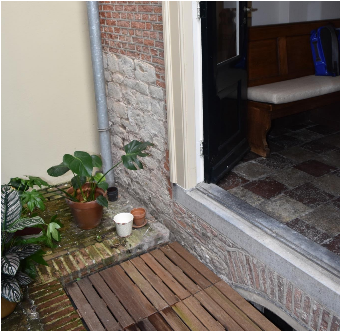
De plint van de voorgevel van het achterhuis, deels voorzien van een bekleding van Lede- of Gobertangersteen (circa 1500). Dit deel van de plint bleef behouden bij de bouwwerkzaamheden van 1607.
