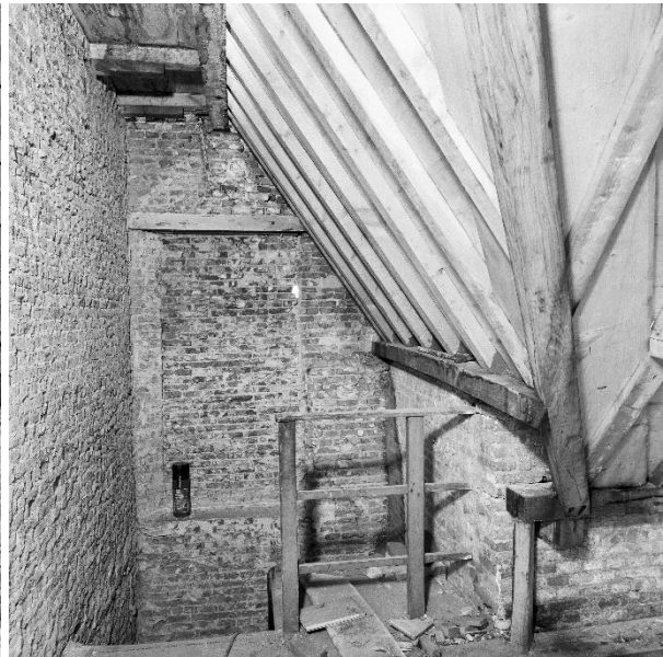
De raveling voor de zoldertrap in het achterhuis (links) en de kap van het achterhuis (rechts) in november 1983, foto's van G.J. Dukker (RCE beeldbank, 246.463 en 246.462).
