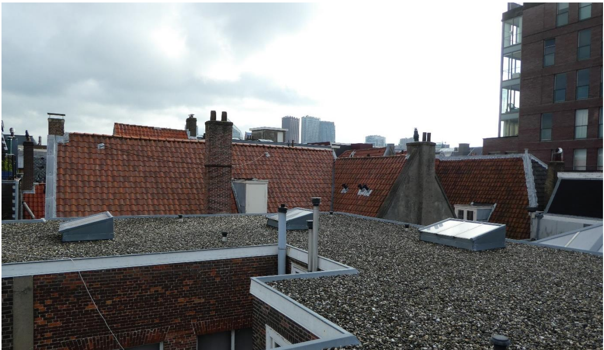
Overzicht van het T-vormige zadeldak van het achterhuis (links) en het L-vormige schilddak van het voorhuis (rechts), gezien vanaf de platte daken van het buurpand. De rookkanalen van het achterhuis zijn vernieuwd bij de restauratie van 1982-'84.
