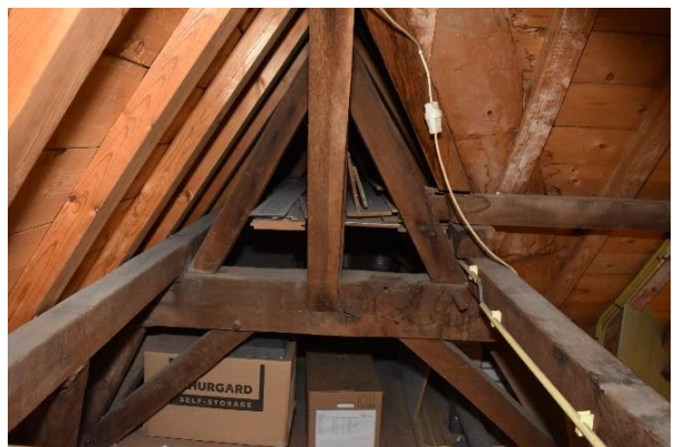
De vliering van de voorzolder van het achterhuis bevat twee spanten, elk bestaande uit een vlieringgebint en nokgebint. De flieringen en nokbalk zijn afgeschoord (windschoren).
