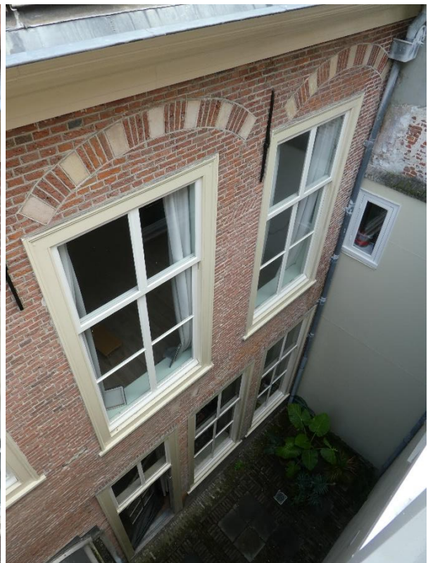
Links: het linkerdeel van de voorgevel van het achterhuis, geheel uitgevoerd in schoon metselwerk. De segmentboogvormige ontlastingsbogen met natuursteen blokken horen bij kruisvensters uit 1607. De huidige vensters hebben een 18 de - en 19 de -eeuwse karakteristiek (geheel vernieuwd bij de restauratie van 1982-'84). Rechts: het rechterdeel van de voorgevel van het achterhuis.
