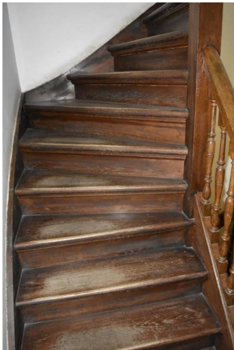
De zoldertrap tussen de eerste verdieping en de zolder. Deze trap is een (vrije) reconstructie uit 1982-'84 van de oorspronkelijke spiltrap naar de schuilkerk uit circa 1630.
