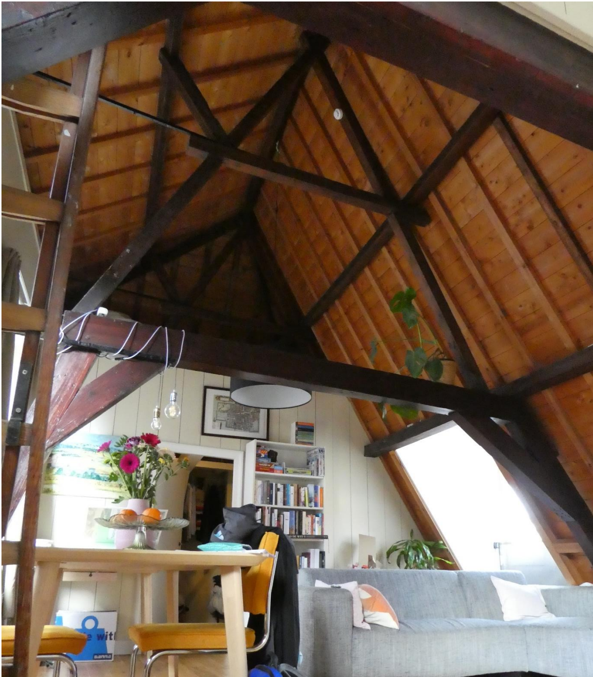
De kapconstructie van het voorhuis.
