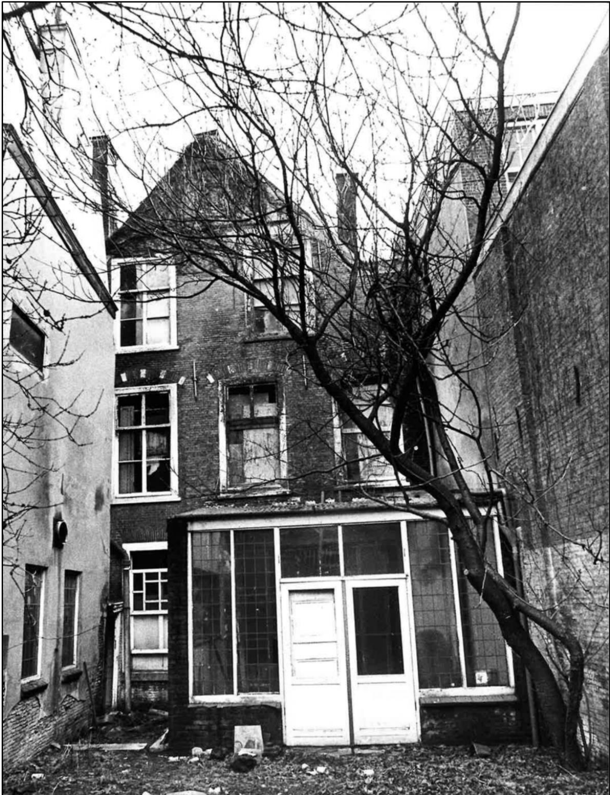
De achtergevel van het achterhuis omstreeks 1982 (Stadsherstel Den Haag, pandsarchief). Op de begane grond is de serre uit 1876 herkenbaar, meermaals verbouwd en gewijzigd. Het middelste venster op de eerste verdieping toont duidelijke brandsporen.
