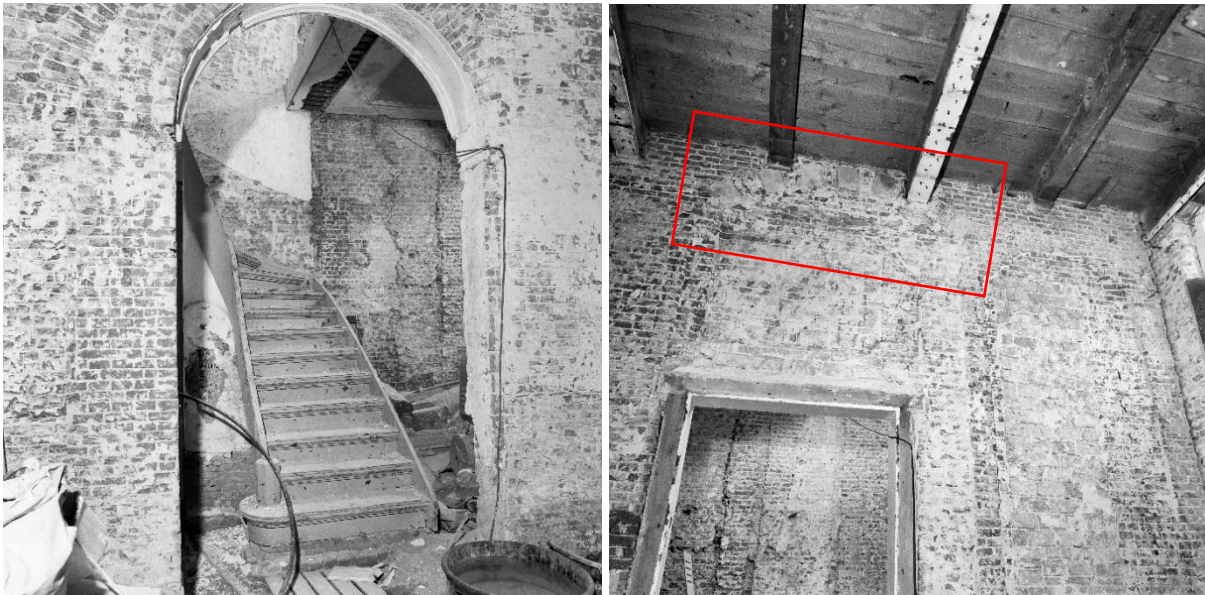
De doorgang naar het trappenhuis en fragment van de achtergevel van de hal op de begane grond van het voorhuis in november 1983, foto's van G.J. Dukker (RCE beeldbank 246.233 en 246.434). In de achtergevel is een segmentboog met natuursteenblokken herkenbaar (omkaderd), vermoedelijk van een deuropening.
