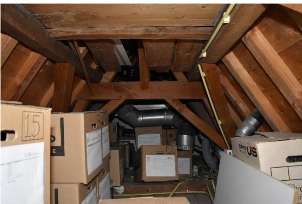
De vliering van de voorzolder van het achterhuis bevat twee spanten, elk bestaande uit een vlieringgebint en nokgebint. De flieringen en nokbalk zijn afgeschoord (windschoren).
