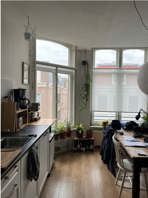
De keuken gezien richting de Boekhorststraat. De vensters zijn voorzien van voorzetramen ter isolatie.
