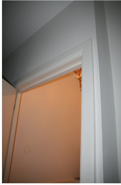
Het geprofileerde deurkozijn van de deur tussen de keuken en de gang. Het kozijn is oorspronkelijk, de deur is nieuw.
