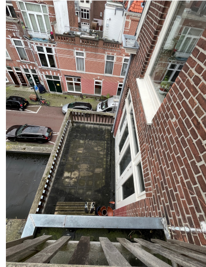
De achtergevel gezien vanaf het balkon van de zolderverdieping. Rechtsboven het venster in de achtergevel van de zolder, met daaronder de pui van de tweede verdieping met balkon.
