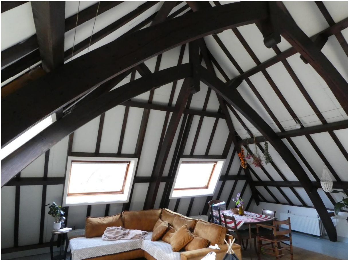
Overzicht van de Philibert- of schenkelspanten op de zolder, vermoedelijk uit circa 1880.
