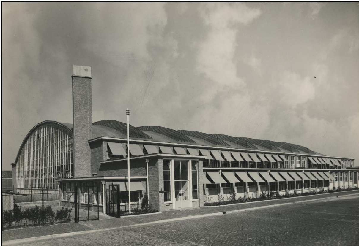
Het fabrieksgebouw van de firma Escher aan de Planeetkade in Den Haag, foto J.W. Durrer in 1957 (HGA beeldbank, nr. 56151). Het exterieur is ontworpen door de architect C.J.Ph. Reinerie jr.
