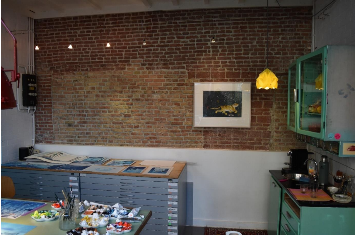
De achterwand van het achterste atelier. Hier is het muurwerk van gele baksteen herkenbaar, dat links aansluit op de hoek van een bijgebouw op het terrein van Nobelstraat 3. Op deze foto is verder een dichtgezette doorgang herkenbaar. In het muurwerk rechts buiten de foto is een beeldnis herkenbaar. De muur is verhoogd.
