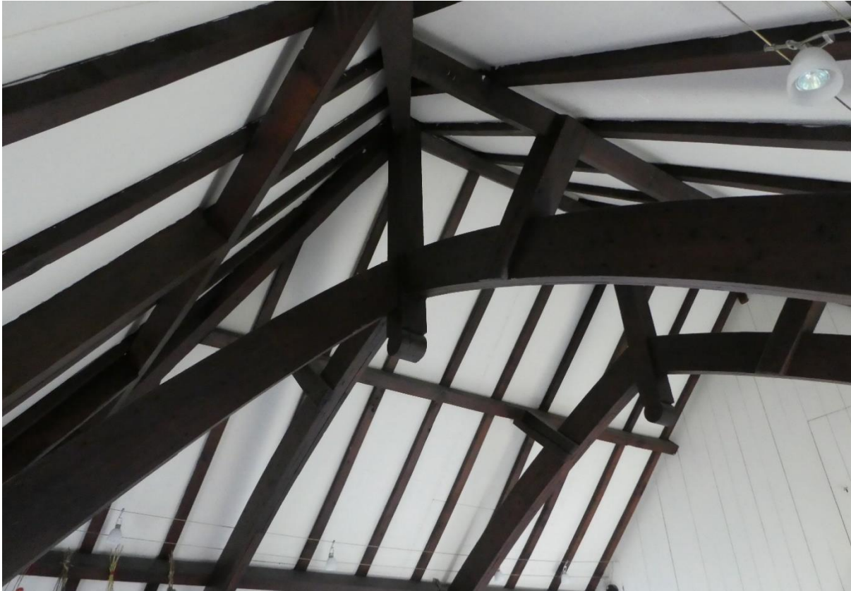
Overzichten van de kapconstructie, gezien naar de voorgevel (boven) en de nok (onder). De schenkel- of Philibertsantanten bestaan alle uit drie lagen planken. Op de nokstijl van het voorste spant sluit een halfspant aan, eveneens samengesteld als een schenkel- of Philibertsantant.
