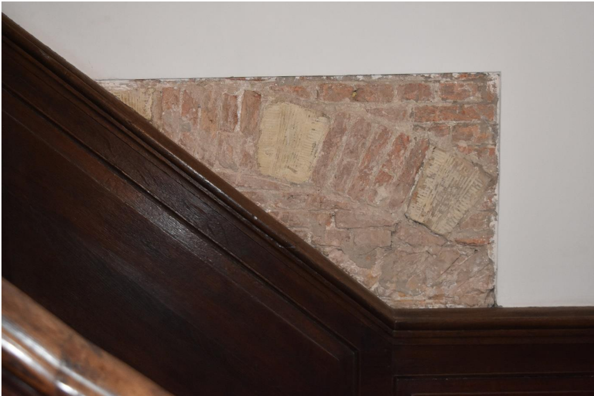
Segmentboog in de achtergevel van een 16 de -eeuwse eenlaags huis, herkenbaar in het 18 de -eeuwse trappenhuis in Oude Molstraat 32.
