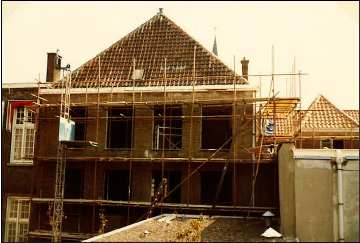
De achtergevel tijdens de restauratie omstreeks 1980, foto van Snoeck aannemersbedrijf BV (archief Stadsherstel). De gevel is ontleisterd, alle stalen vensters uit 1949 zijn verwijderd. Op deze foto zijn nog de grote vensteropeningen op de tweede verdieping herkenbaar, die naderhand zijn verkleind tot mezzanine-vensters.
