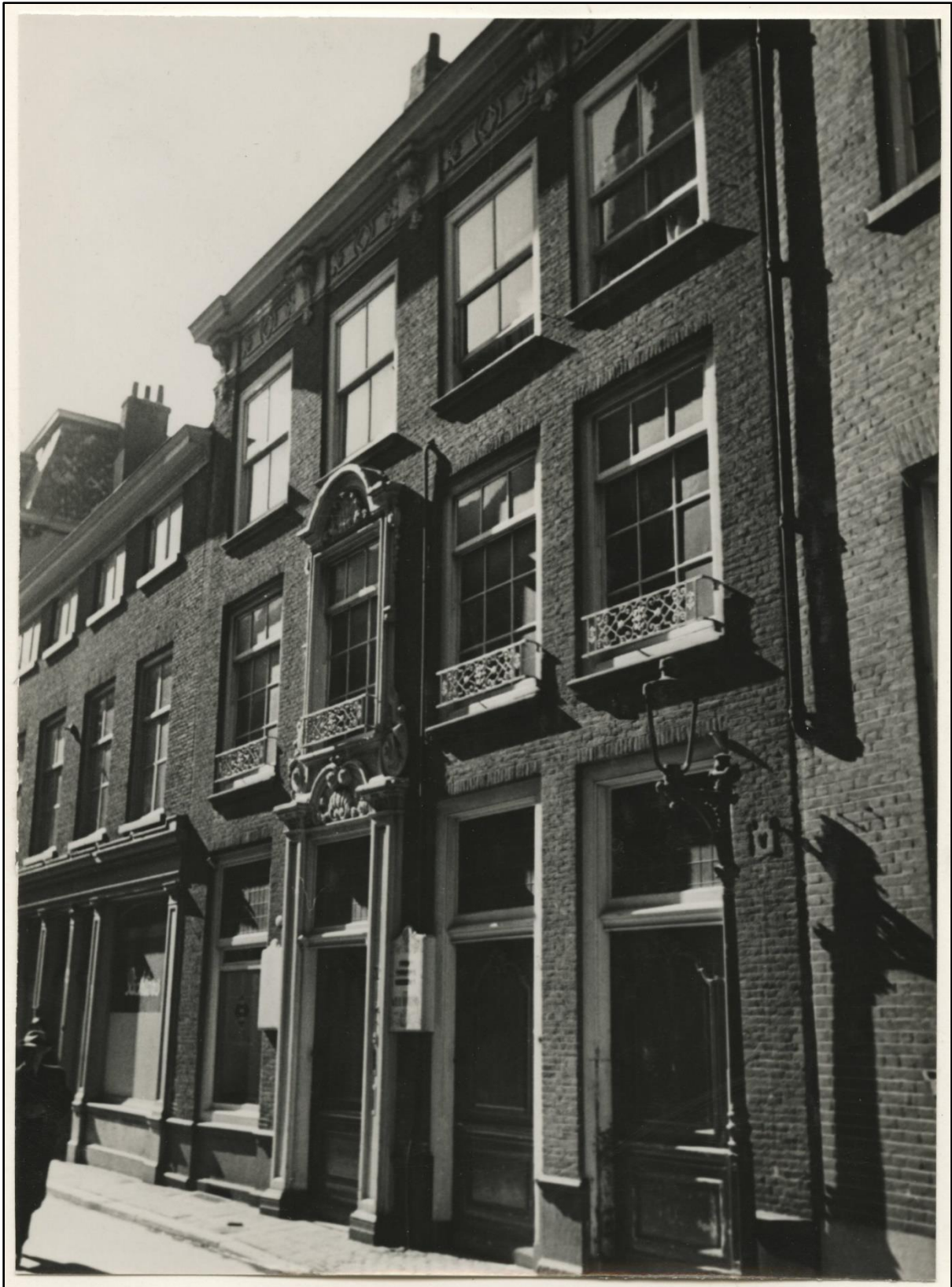
Voorgevel van Oude Molstraat 32 in circa 1943, foto van Van Ojen (HGA, beeldbank nr. 053606). De twee vensters aan de rechterzijde van de begane grond zijn in 1923 verlengd tot deuropeningen, voorzien van kopieën van de 18 de -eeuwse deur en bovenlichten met glas-in-lood.
