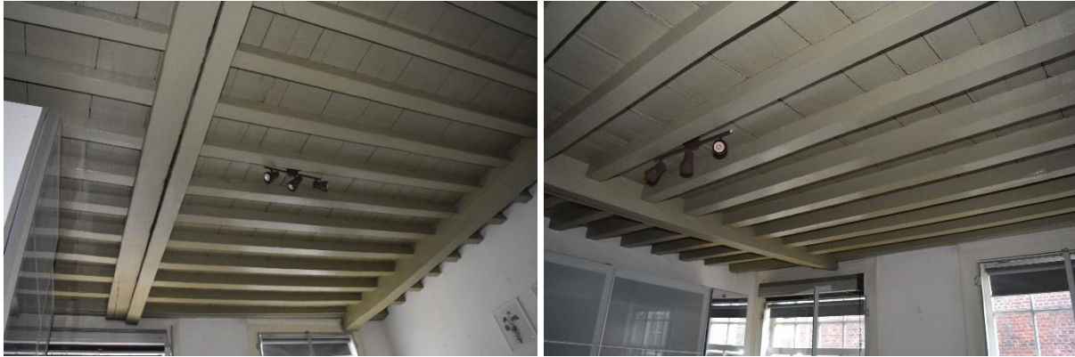
De samengestelde balklagen van moer- en kinderbalken boven de voorkamers op de eerste verdieping, vermoedelijk uit de late 17 de eeuw.
