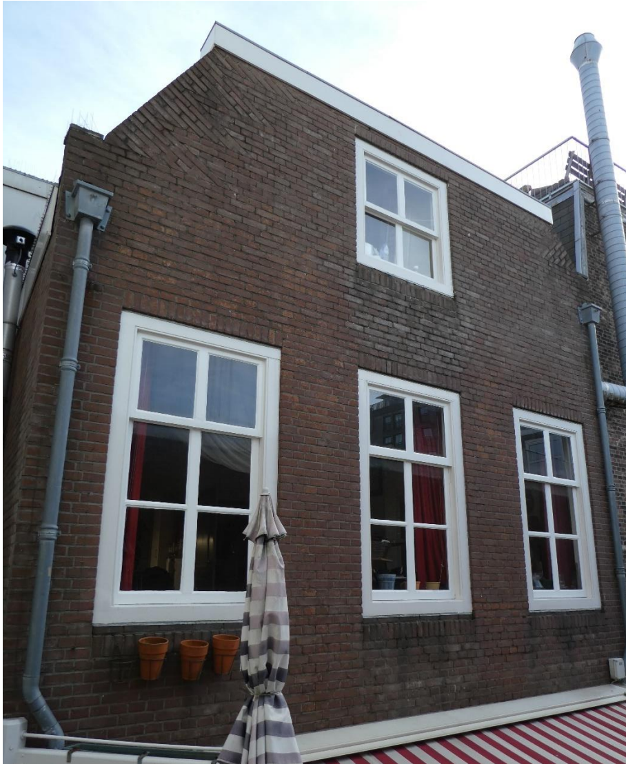
Het bovenste deel van de achtergevel van Oude Molstraat 30, geheel vernieuwd bij de restauratie van 1980-'82.
