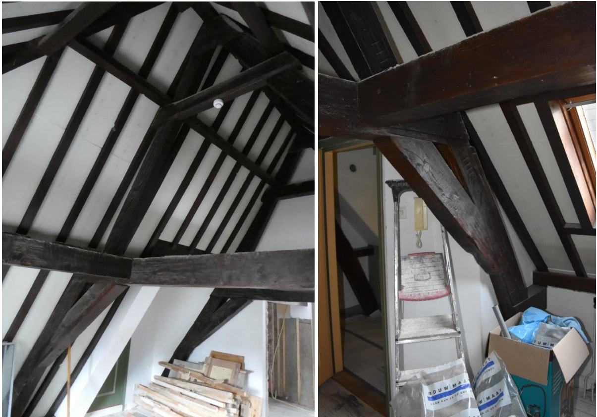
De kapconstructie van de dwarsvleugel, waarvan de stapelspanten en flieringen vermoedelijk uit circa 1632 dateren.
