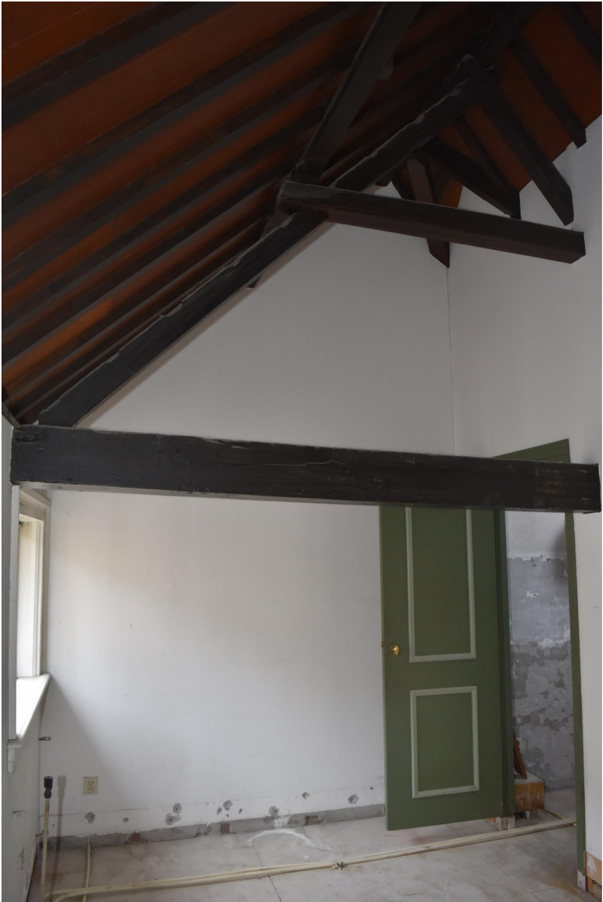
Overzicht van de zolderruimte van de voorvleugel, waarvan de kapconstructie bestaat uit een balk (tussen voorgevel en gebint van de dwarsvleugel) en een A-gebint.
