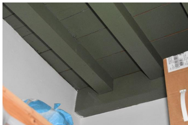
Links: de samengestelde balklaag in de rechter voorkamer op de eerste verdieping, bestaande uit grenenhouten moer- en kinderbinten uit de late 17 de eeuw.
