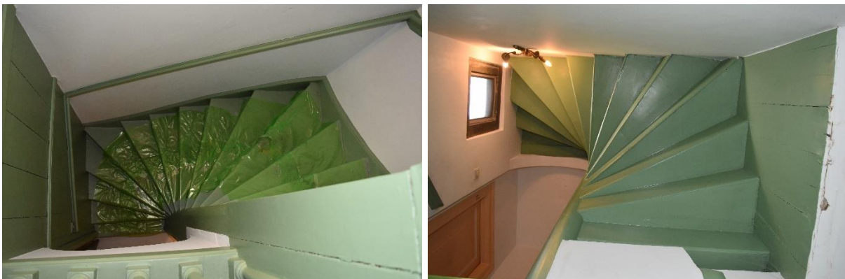
Links: bovenaanzicht van de spiltrap, gezien vanaf de zolder van de dwarsvleugel. De trap is afgedekt met plakfolie ten behoeve van bouwverkeer.
