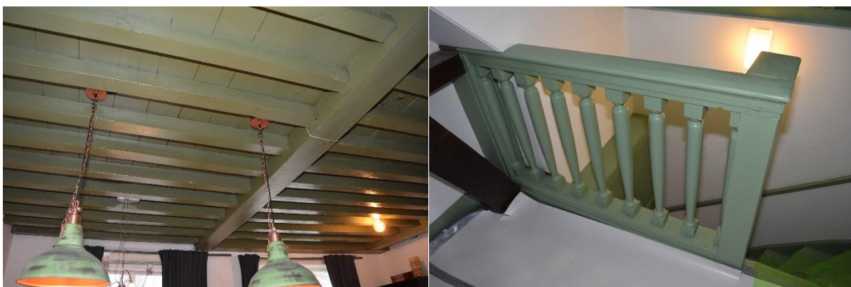
Links: de grenenhouten balklaag van moer- en kinderbinten boven de eerste verdieping, vermoedelijk uit circa 1687.
