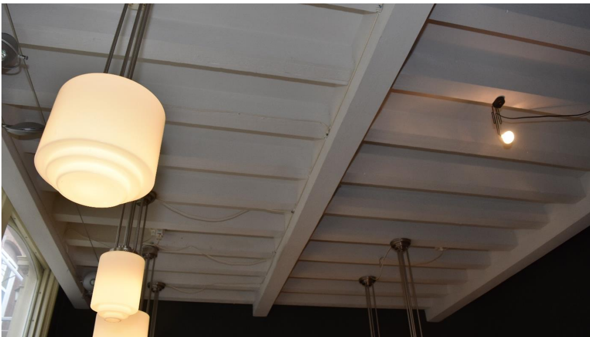
Het verlaagde plafond boven de linker voorkamer op de begane grond (winkelruimte) is een herinnering aan de balklaag van moer- en kinderbinten, die bij de restauratie van 1980-'82 vernieuwd moest worden.
