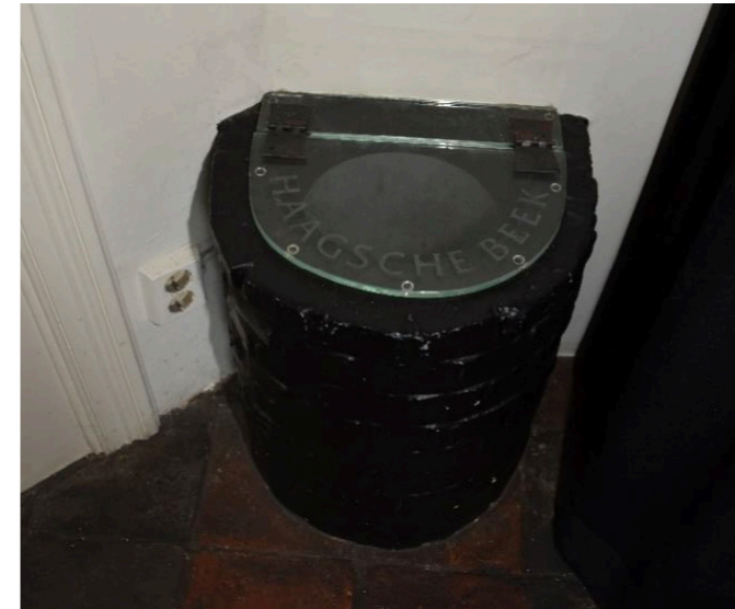
De kleine put op de begane grond van het restaurant, gerealiseerd bij de restauratie omstreeks 1980 als kijkgat in de waterput (15e eeuw/ 1622). Deze put heeft een deksel van plexiglas met de tekst: 'Haagsche beek'.29
