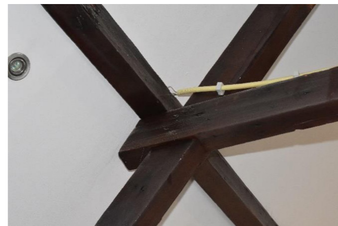
De vernagelde aansluiting van de tussenbalk op de spantbenen van het vlieringgebint, waarop een fliering aansluit.
