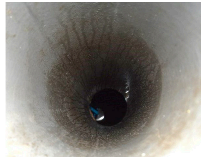
Doorzicht in de waterput. In de middencirkel is het aangelichte water in de put herkenbaar.
