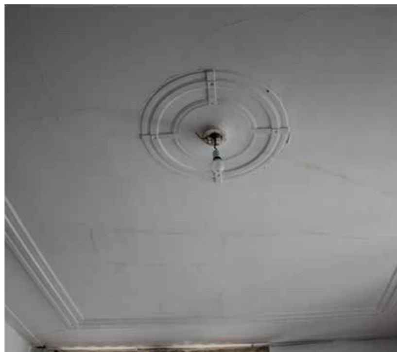
Oorspronkelijk plafond op de verdieping
