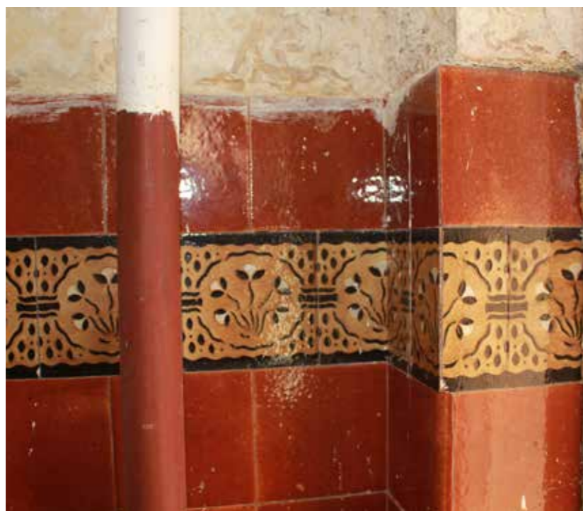
Oorspronkelijke tegel-lambri in hal op de bg. achter de entree aan de Dintelstraat
