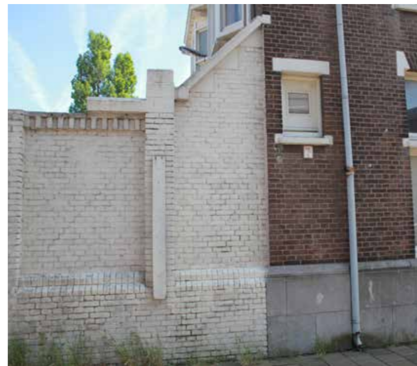
Oorspronkelijke aansluiting van het hek met het kantoorgebouw aan de Zwetstraat
