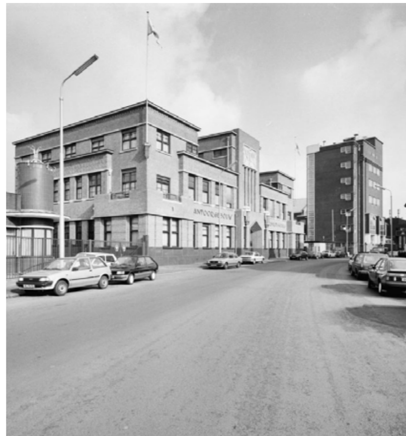
Hoofdkantoor De Drie Hoefijzers in Breda, gebouwd in 1927
