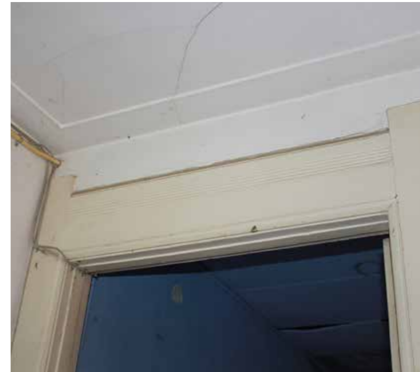
Originele deuromlijsting op de verdieping
