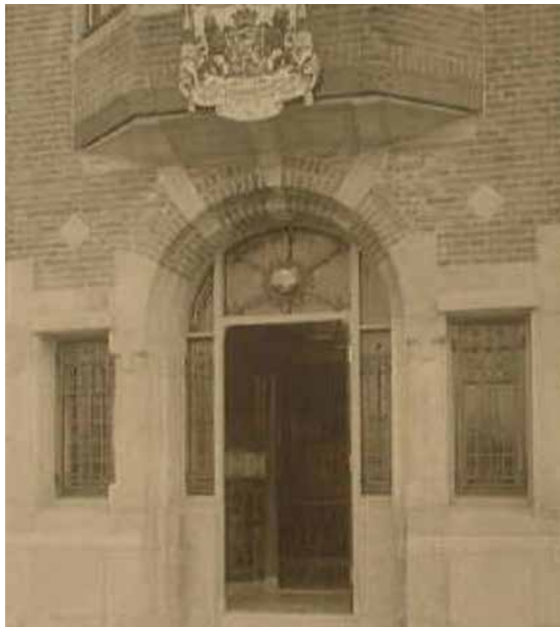
Entree van het kantoor aan de Zwetstraat, ca. 1913
