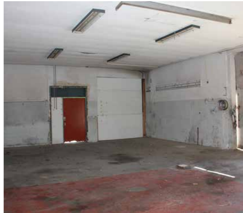
Interieur stal met in de vloer aanzet van de gietijzeren kolommen
