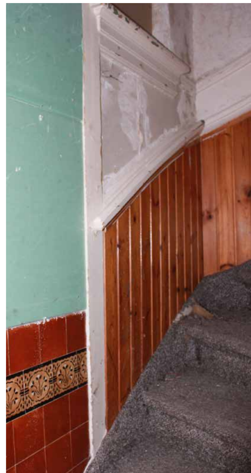
Trappenhuis gezien vanaf de begane grond naar de eerste verdieping
