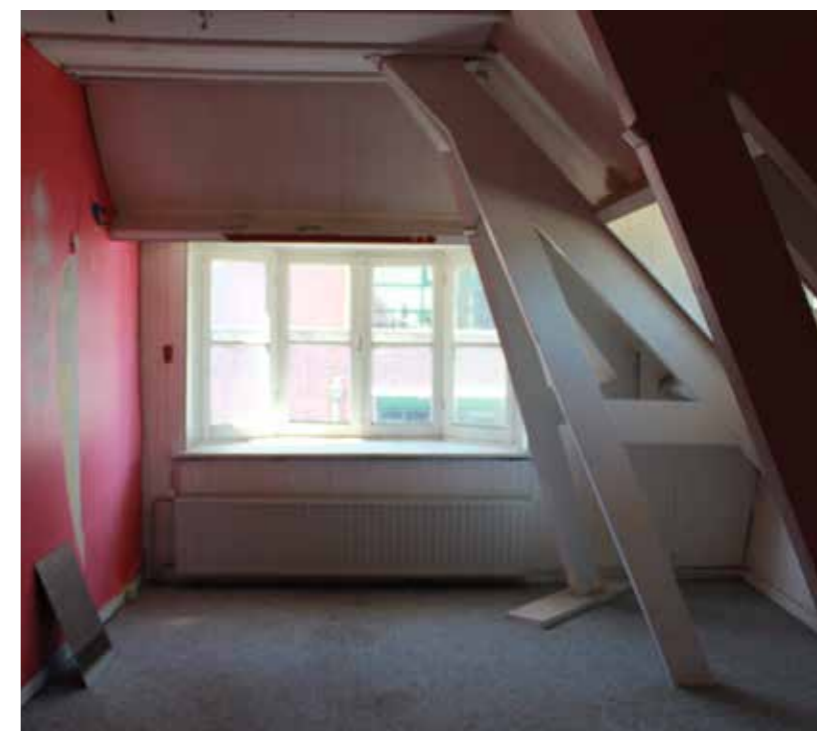
Ruimte op de tweede verdieping met houten kasspanen
