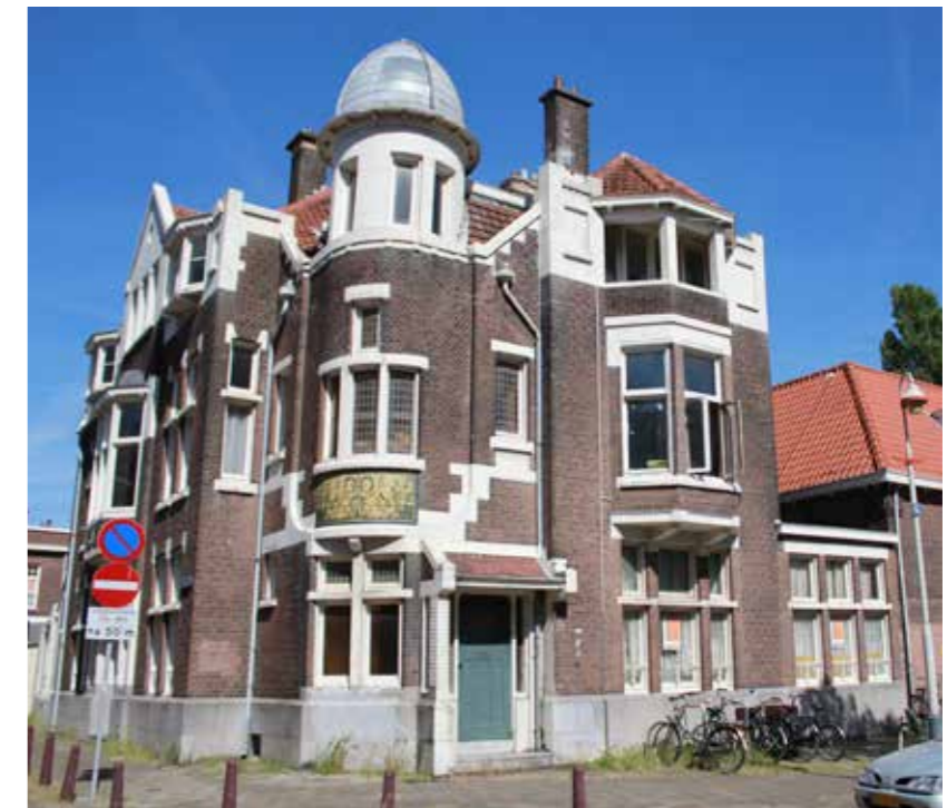
Gevel Kantoorgebouw aan de Dintelstraat
