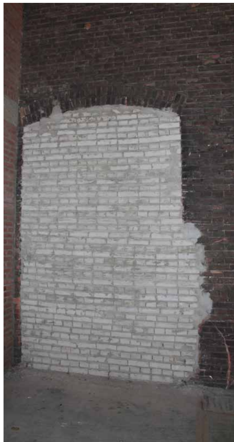
Voormalige gevelopening in de noord-oostgevel
