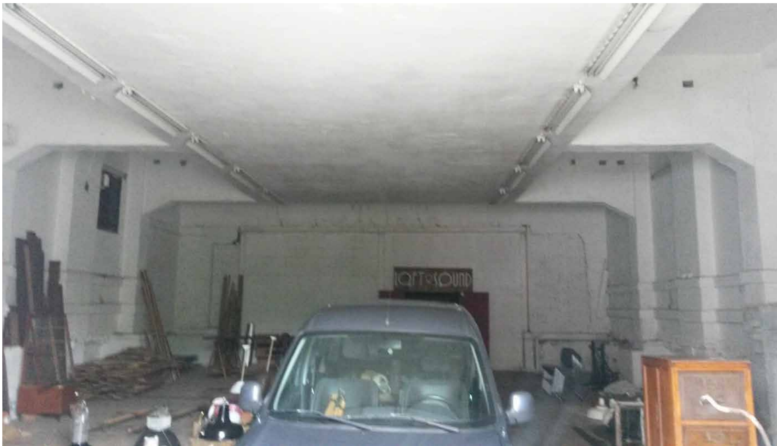
Interieur van de bierkelder met de daarin "hangende" ijszolder
