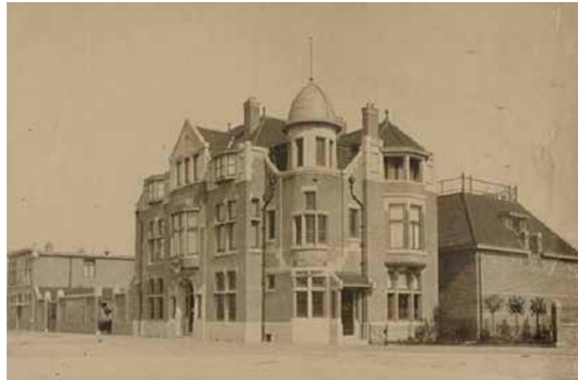
Het kantoor met rechts het koelhuis, ca. 1913
