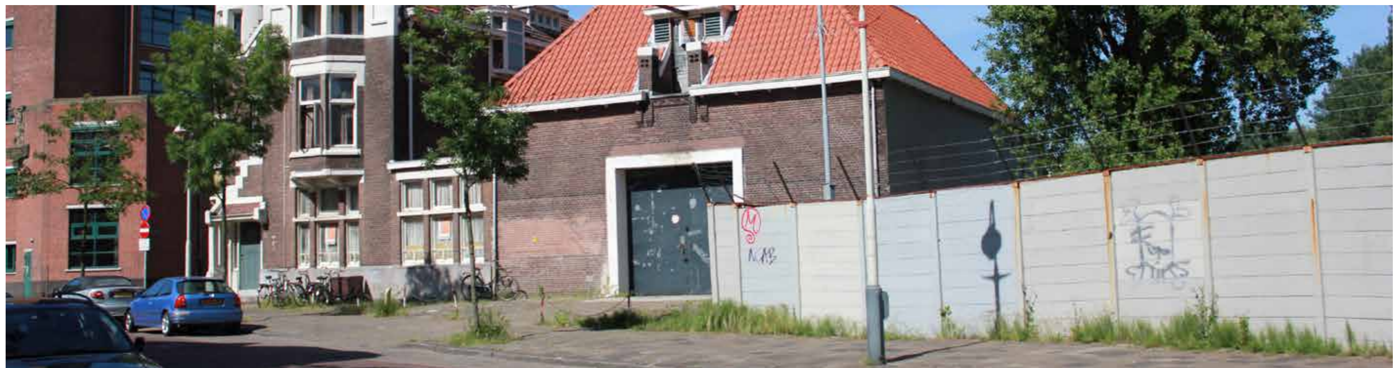
Betonnen afscheiding (Dintelstraat) van het parkeerterrein achter het complex
