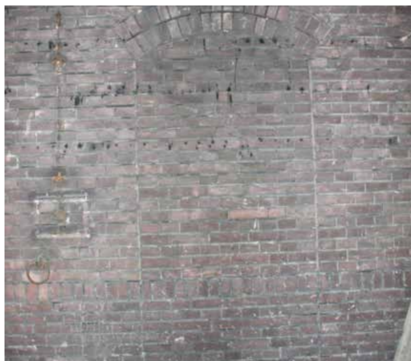
Voormalige gevelopening in de noord-oostgevel
