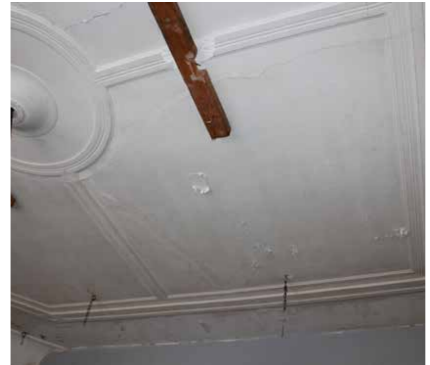
Gipsplafond in oostelijke kamer op de verdieping
