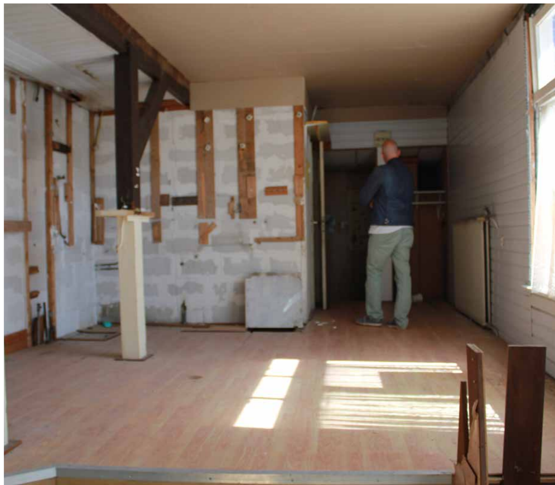
Verhoogde vloer in ruimte aan de zuid-oostgevel, boven de stal
