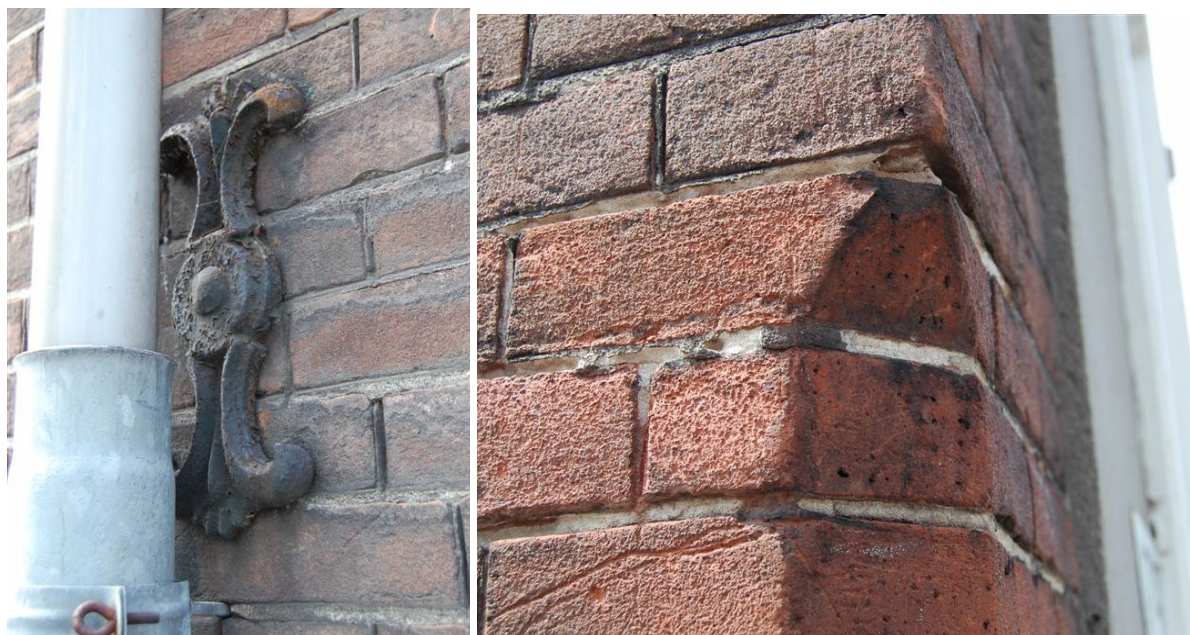
Links: het anker in het midden van de begane grond van de voorgevel, behorende bij de houtconstructie tussen beide bedrijfsruimten.
