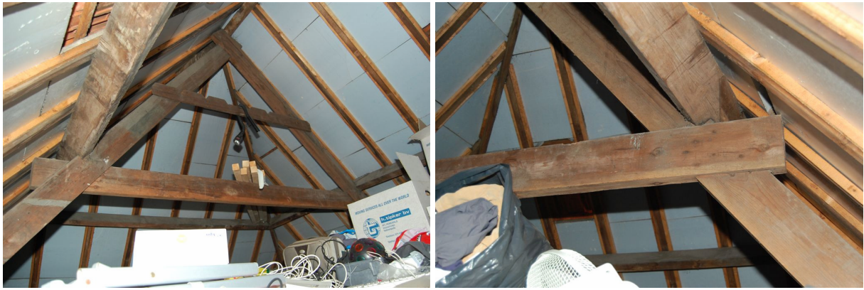
Links: overzicht van de kapconstructie van de linkerwoning (Zuidwal 1b). Herkenbaar is het voorste A-spant. De zoldervloer is gesloopt om op de tweede verdieping meer hoogte te kunnen geven. Rechts: detail van het achterste A-spant in de linkerwoning.
