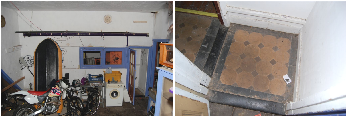
Links: achterwand van de kantoorruimten in het voorste deel van de rechter bedrijfsruimte op de begane grond (1902?). In deze wand zijn een tweelichtvenster en een kozijn met een glasdeur zichtbaar. Rechts: gedeelte van de tegelvloer in het portaal van de kantoorruimte in de rechter bedrijfsruimte op de begane grond (1902?).
