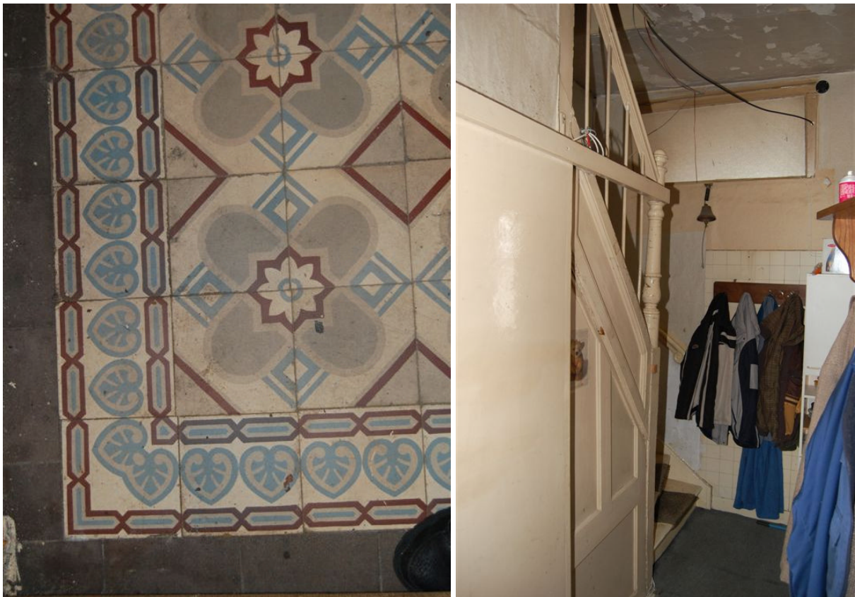
Links: detail van de vloer van dubbel hardgebakken tegels in de entreehal op de begane grond van de rechter bovenwoning (Paviljoensgracht 139).
