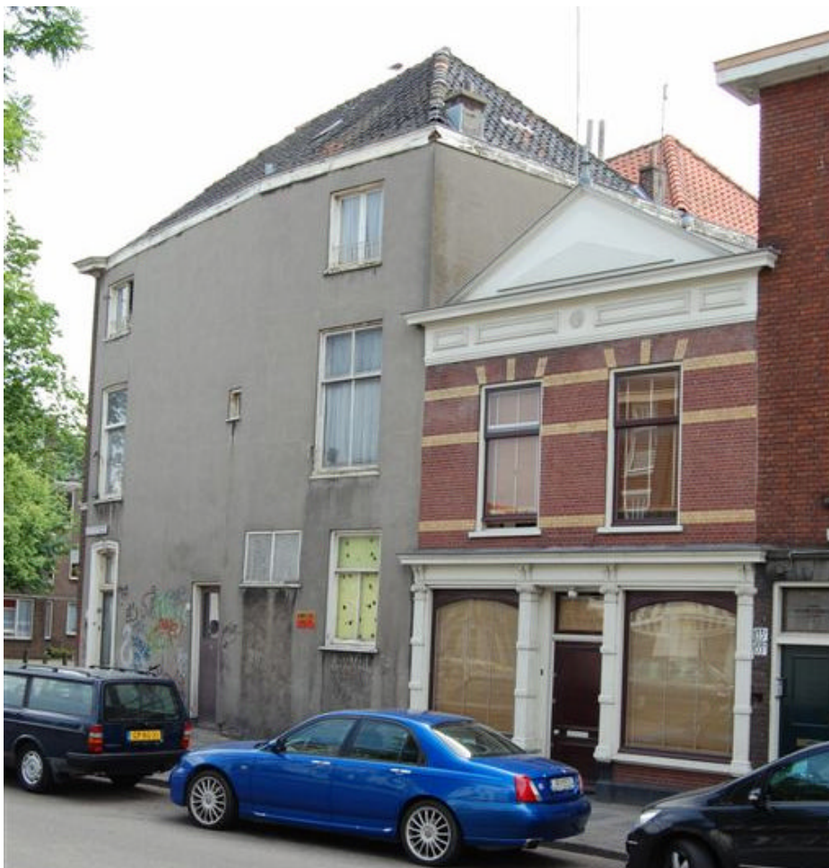
Overhoeks aanzicht van de rechterzijgevel en de achtergevel. Het zicht op de achtergevel wordt grotendeels afgeschermd door het naastgelegen pand, Paviljoensgracht 137. Wel vallen beide daken te herkennen, respectievelijk gedekt met gesmoorde Oudhollandse en rode pannen.
