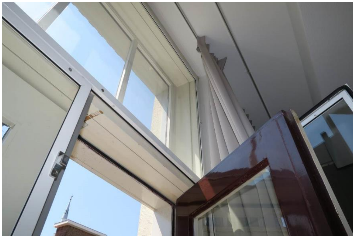
Afb.D12 Eerste verdieping voorkamer huisnummer 7 zijde Wagenstraat. Detail deurkozijn voorgevel met achterzetbeglazing. [ GVB architecten 2023 ]
