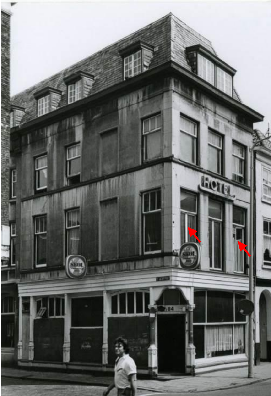
Afb.C41 Foto gedateerd 1979. Alhoewel flink verwaarloosd bevindt het pand zich in de toestand zoals die met de verbouwing in 1920 is gerealiseerd. Er zijn diverse verschillen op detailniveau te zien met de huidige toestand zoals de uitvoering van de dakkapellen, de vensters in de voorgevel met lage onderdorpels en de pui-verdeling zijde Wagenstraat. [ beeldcollectie Haags Gemeentearchief ]
