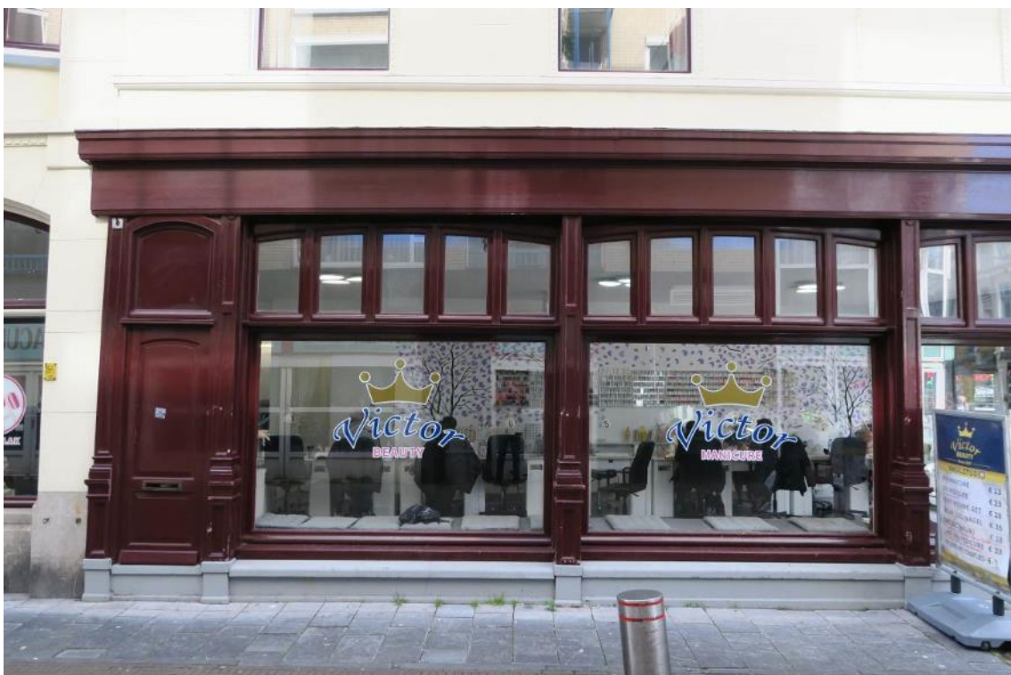
Afb.D3 Zijde St.Jacobstraat. Op de plint en de kolommen na dateert de gehele winkelpui uit 1993. De deur links is een oud gegeven als zelfstandige entree van de voormalige oude bovenwoning. Met de verbouwing in 1920 werden de panden verheeld en werd de opgang naar boven gesloopt. De oude deur is toen verwijderd en mogelijk vervangen door een vaste glasruit. Vandaar de doorgetrokken plint. In 1993 heeft men een deur zonder functie terug gerestaureerd. [ GVB architecten 2023 ]
