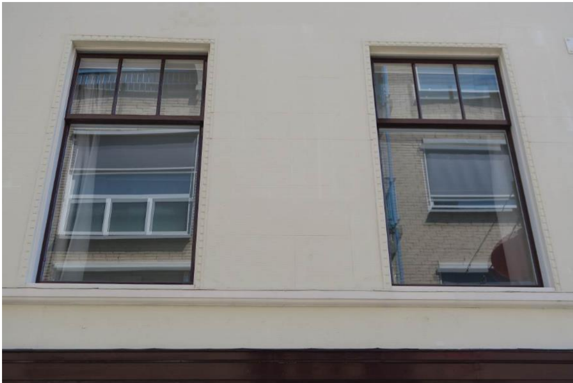
Afb.D8 Gevel zijde St.Jacobstraat eerste verdieping. De ramen en waarschijnlijk ook de kozijnen zijn in 1993 vernieuwd en voorzien van achterzetbeglazing. [ GVB architecten 2023 ]
