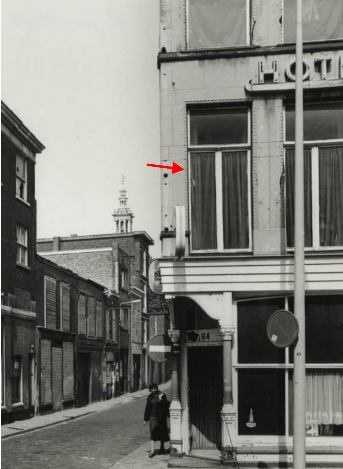
Afb.C42 Foto gedateerd 1979. De nog bestaande kolommen bij de entree behoren bij de bouwphase van de winkelpui uit 1897. Met de bouwphase 1920 zijn de gevels voorzien van stucwerk dat is bewerkt met diverse versiering, accenten en karakteristiek kamwerk. Dit is nog steeds aanwezig. [ beeldcollectie Haags Gemeentearchief ]
