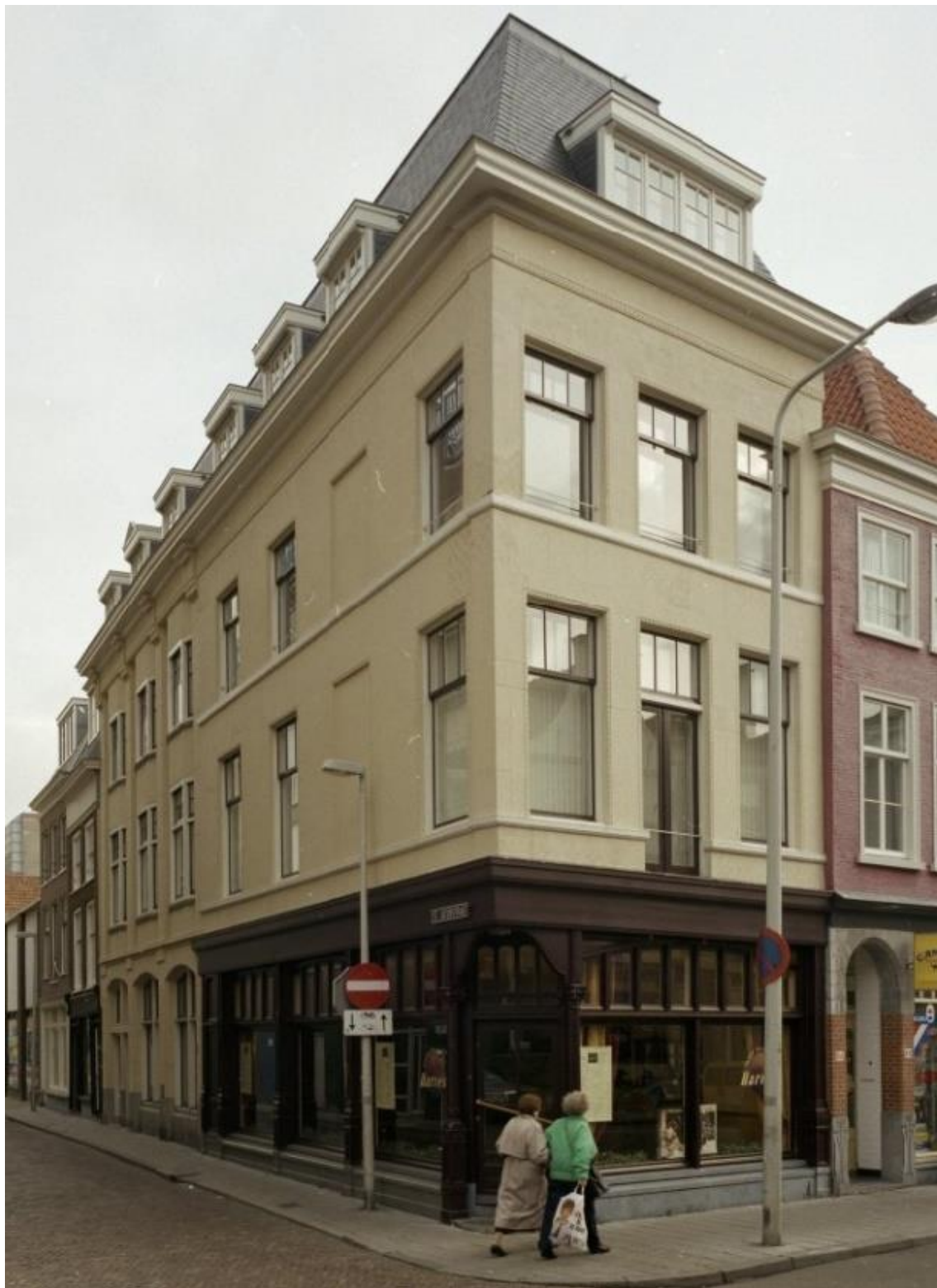
Afb.C44 Foto gedateerd 1995 toestand kort na oplevering van het renovatieplan in opdracht van Stadsherstel dat heeft geleid tot de huidige toestand. Als gevolg van de slechte toestand waarin het complex zich uiteindelijk bevond is er met de renovatie veel vernieuwd en ook terug gerestaureerd. Vernieuwd cq gewijzigd zijn o.a. de etalage met plint en lijstwerk zijde Wagenstraat, het deurkozijn en de etalage met lijstwerk zijde St.Jacobstraat, Alle ramen en vermoedelijk ook alle kozijnen op de eerste en tweede verdieping (met wijziging vensters voorgevel), de kap met gootlijst en dakkapellen. [ beeldcollectie Haags Gemeentearchief ]
