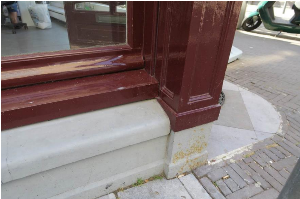
Afb.D5 Detail zijde St.Jacobstraat. Kozijn pui dateert uit 1993. De plint lijkt nog authentiek behorend bij de bouwfase 1920. De kolommen dateren uit de bouwfase 1897. [ GVB architecten 2023 ]
