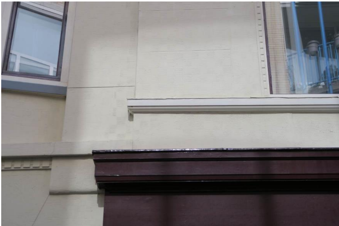
Afb.D9 Gevel zijde St.Jacobstraat op de scheiding met de buurgevel uit de bouwphase 1920. Op de foto slecht zichtbaar maar beide gevels zijn op gelijke wijze afgewerkt met stucwerk dat is voorzien van karakteristiek kamwerk. [ GVB architecten 2023 ]
