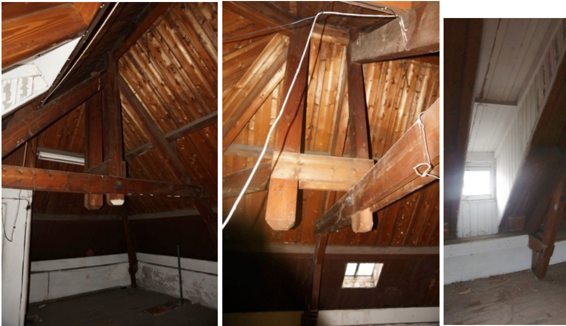
Afbeelding 55, 56 en 57 Spantbalken, spantbenen en makelaar zolder 4A en 4B. Uiterst rechts: houten schroten dakkapellen (foto's auteur 2013)
