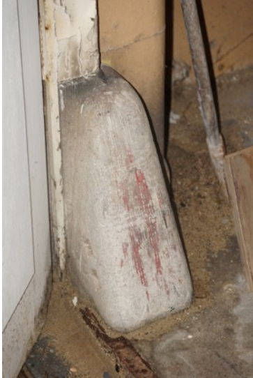
Afbeelding 18 Stootblok in de garage voor het afrijbrik (foto auteur 2013)
