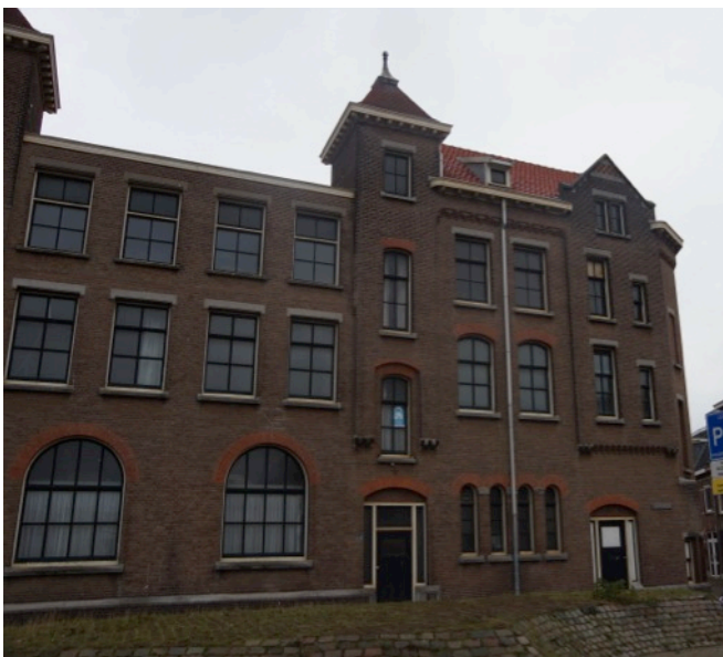
Afbeelding 11 Oostgevel, zijde Schipperplein (foto auteur, november 2013)
