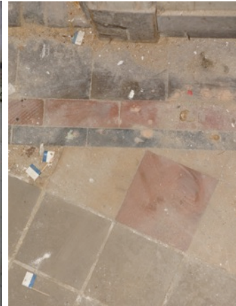
Afbeelding 20 Vloerbedekking in de vorm van keramische, matte tegels op de vloer van de badkamer van de machinist (foto auteur 2013)
