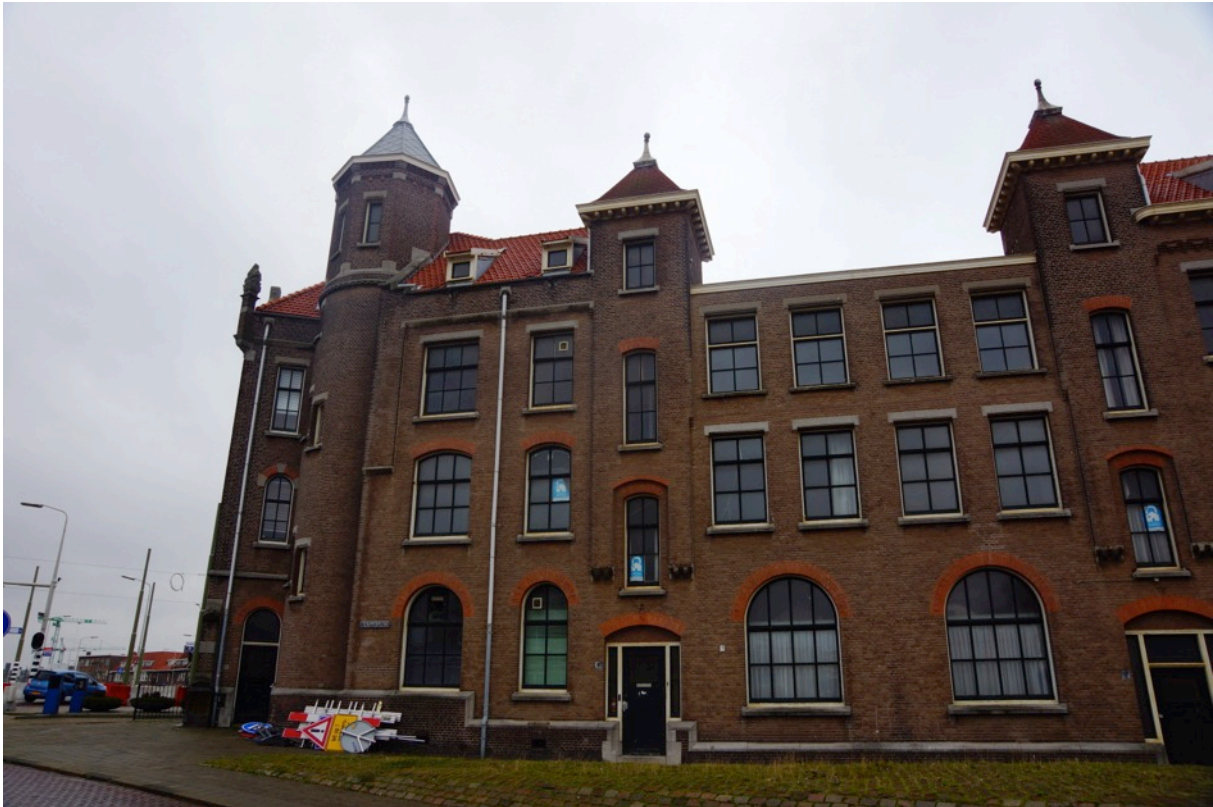
Afbeelding 9 Oostgevel, zijde Schipperplein (foto auteur, november 2013)
