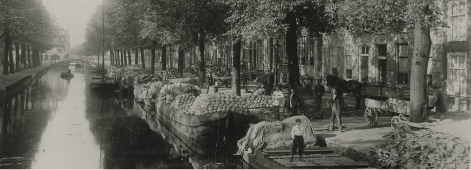
Afbeelding 27 (boven) – Prinsegracht gezicht vanaf de brug t.h.v. de Warmoezierstraat richting Lijnbaan, fotograaf J.A. de Gilde, ca. 1900 (Collectie Haags Gemeentearchief).
