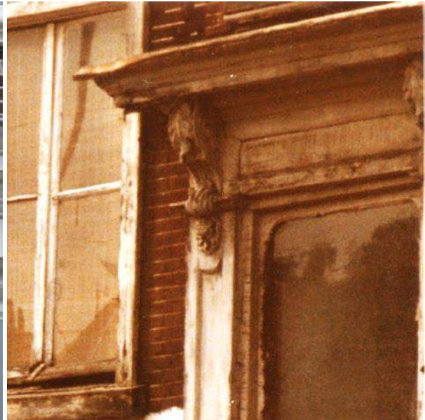
Afbeelding 61 (links) – Detail van de linkerbovenhoek van de deuroplijsting Prinsegracht 285 in de huidige toestand (Foto auteur, mei 2023).
