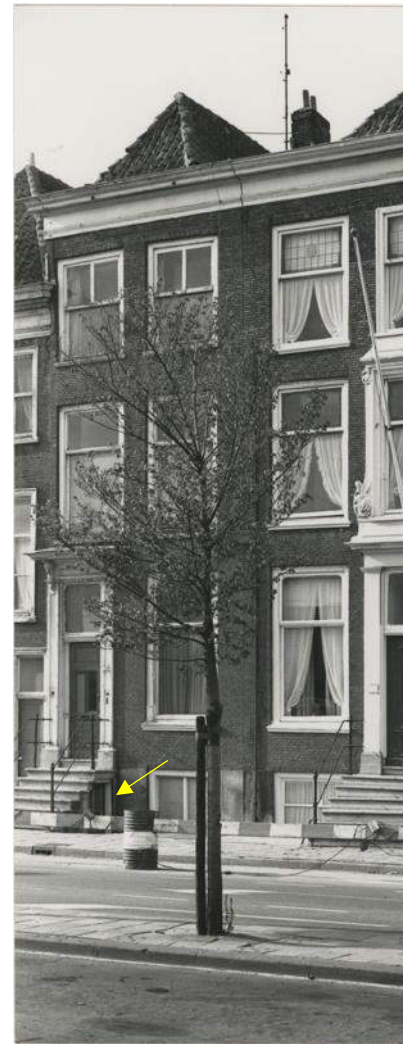
Afbeelding 60 – Onder de bordestrap van het pand Prinsegracht 103 bevond zich een deur naar het souterrain. Foto Dienst Stadsontwikkeling en Volkshuisvesting, ca. 1977. De entree bevond zich ter plaatse van de gele pijl (Collectie gemeentearchief Den Haag).
