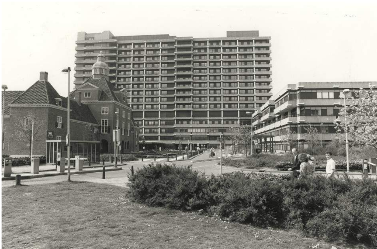
Afbeelding 30 – Westeinde ziekenhuis gezien vanaf de Lange Lombardstraat, links de achterzijde van het Hofje van Nieuwkoop. De schaalvergroting binnen de Prinsegrachtkwartier is duidelijk zichtbaar. Fotograaf Lilian Philips, ca. 1990 (Collectie gemeentearchief Den Haag).
