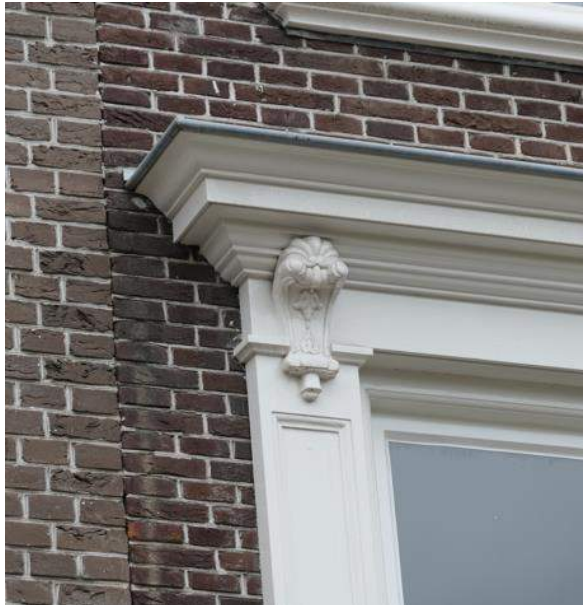
Afbeelding 61 (links) – Detail van de linkerbovenhoek van de deuroplijsting Prinsegracht 285 in de huidige toestand (Foto auteur, mei 2023).
