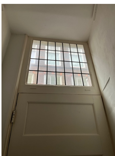
Het bovenlicht van de voordeur betreft een kiepraam.
