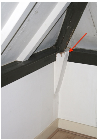
Rechter hoek tegen de voorgevel. De pijl wijst op een vermoedelijk restant van een vóórgaande kapconstructie.
