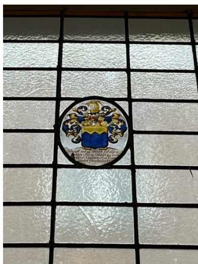
Glas-in-lood, detail van het bovenlicht van de buitendeur die het trappenhuis ontsluit.
