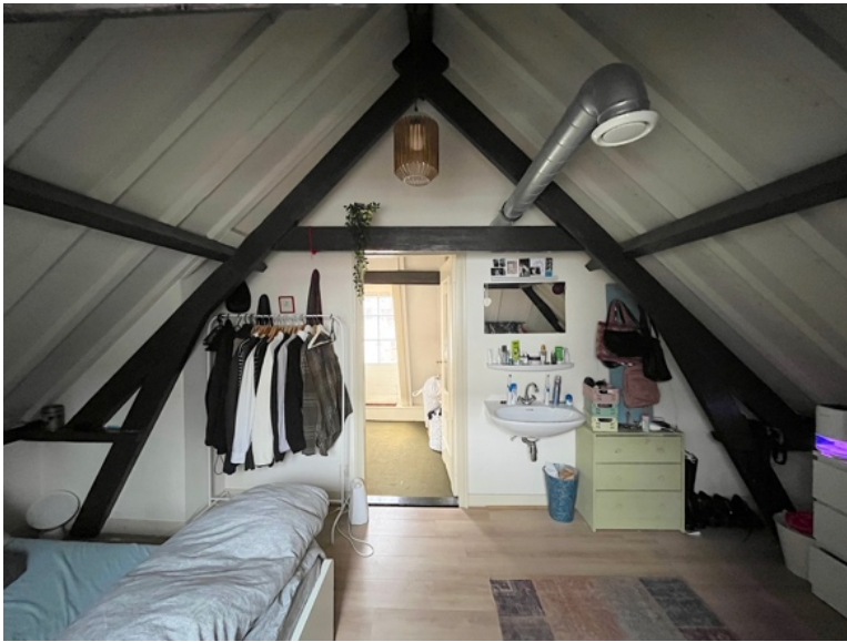
De zolder van Oude Molstraat 20 (linker bovenwoning) gezien richting de achterzijde.
