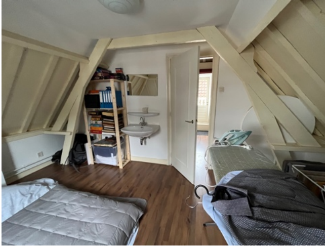
De zolder gezien richting de achterzijde.
