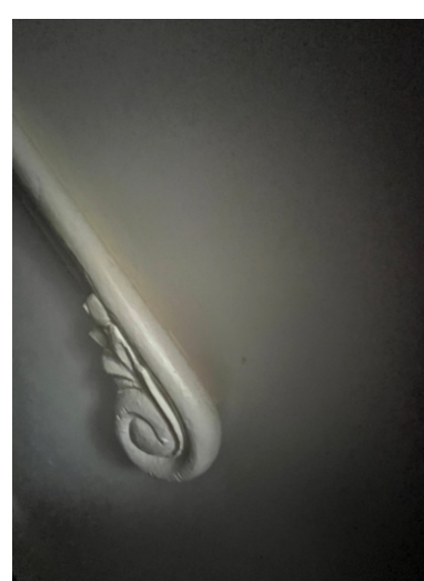
Rijk geprofileerde krul onderaan de handgreep van de trap naar de eerste verdieping.
