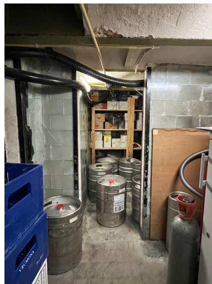
Het centrale grondvat gezien naar het achterste reservoir.
