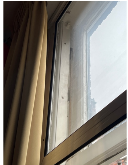
Linker foto: De zijkamer gezien richting de voorgevel. Rechter foto: detail van het linker venster in de voorgevel met in de dagkant de katrol van een touw van het schuifvenster.
