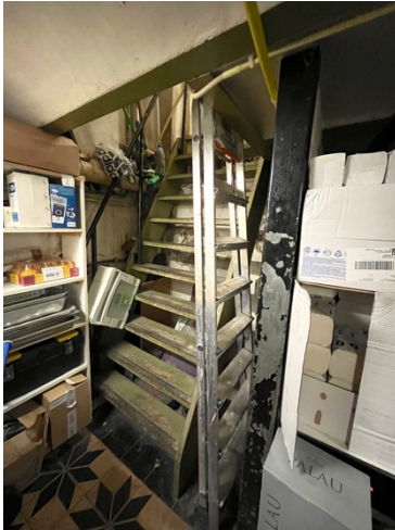
Keldertrap die is ontsloten vanuit de huidige keuken op de begane grond.
