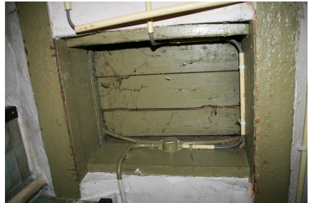
Het luik bovenin het middelste grondvat. Daarnaast is geheel links op de foto een gedeelte van een peilgat zichtbaar.
