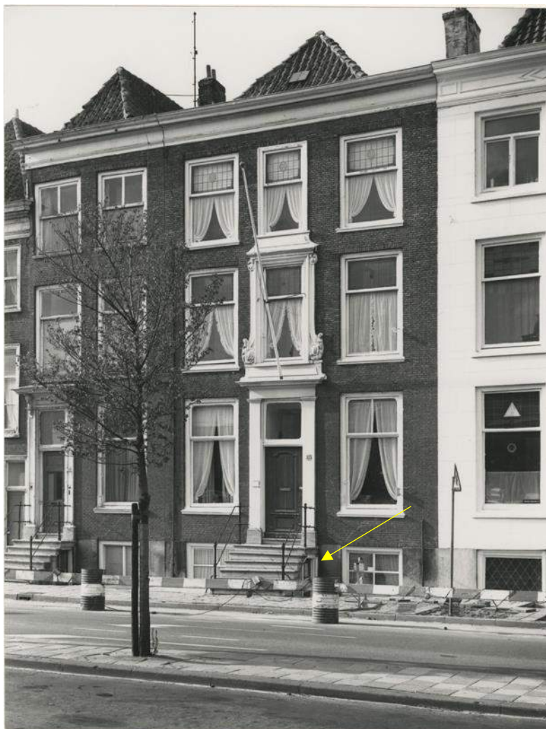
Afbeelding 68 – Onder de bordestrap van het pand Prinsegracht 103 bevond zich een deur naar het souterrain. Foto Dienst Stadsontwikkeling en Volkshuisvesting, ca. 1977. De entree bevond zich ter plaatse van de gele pijl (Collectie gemeentearchief Den Haag).
