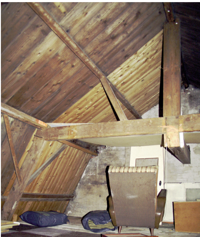
Afb. 63) Rechts: dekbalk en spantbeen zijn traditioneel bevestigd met toognagels.
