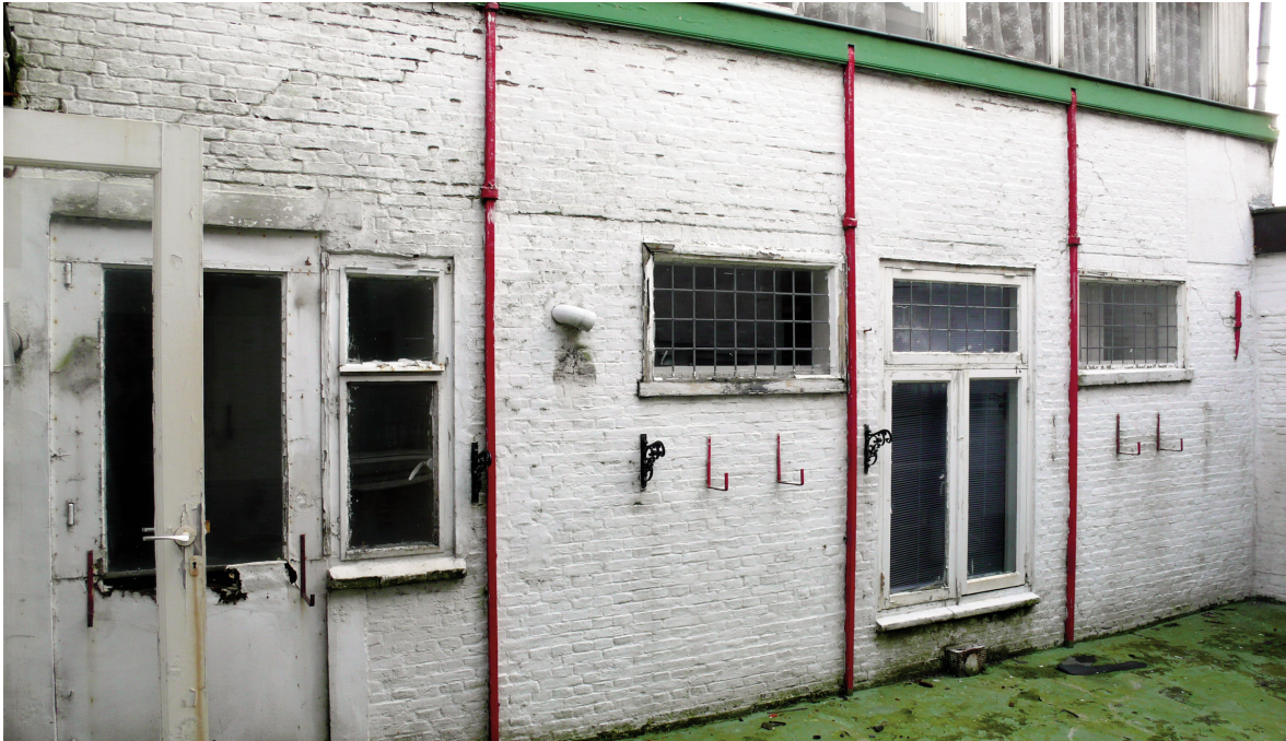
Afb. 52) De rechter zijgevel van het pakhuis bij de binnenplaats.
