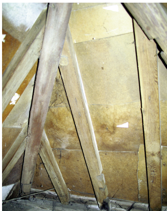
Afb. 48) Rechts: de oorspronkelijk sporen zijn bij de voorgevel nog aanwezig en blijken tevens hergebruikt in de dwarskap.
