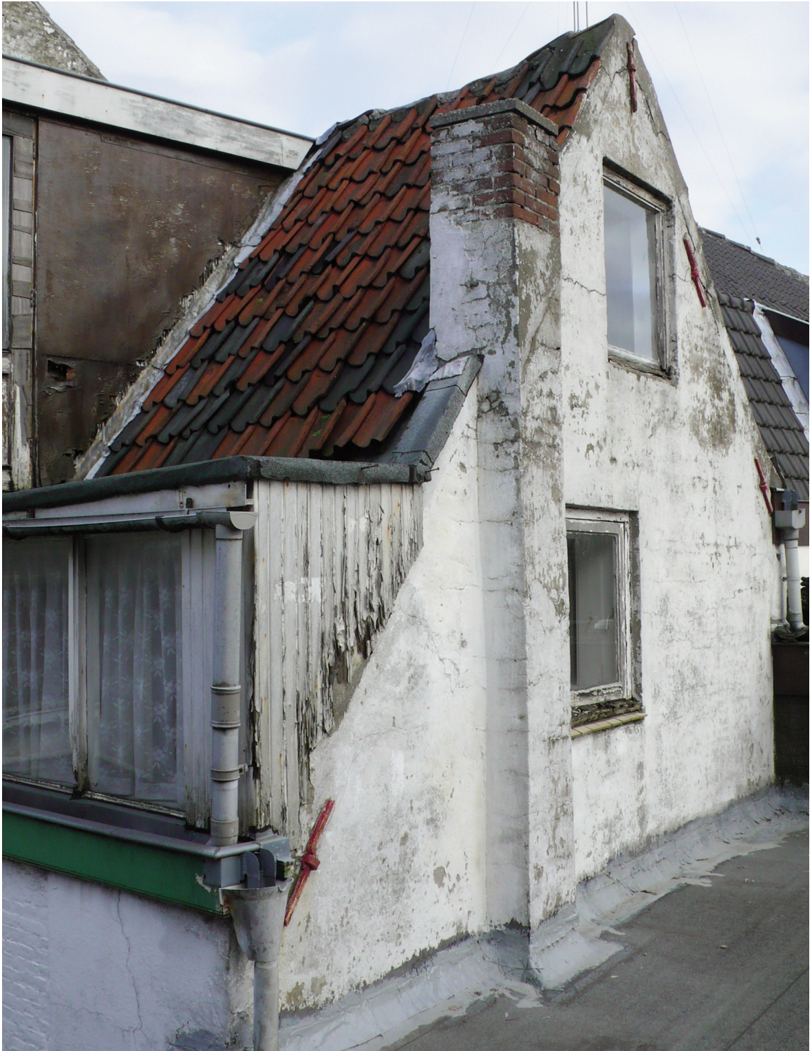
Afb. 54) De achtergevel van het lage deel van het pakhuis.
