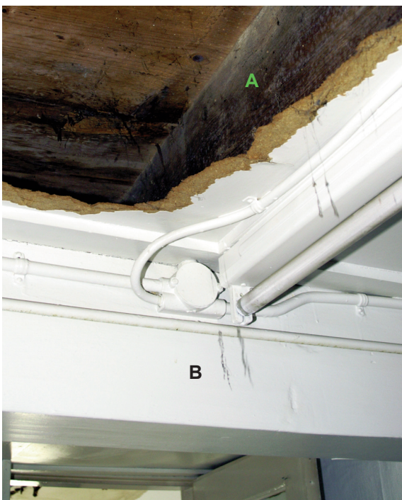
Afb. 59) Rechts: het luik in de balklaag achter de voorgevel van het pakhuis (tweede verdieping).
