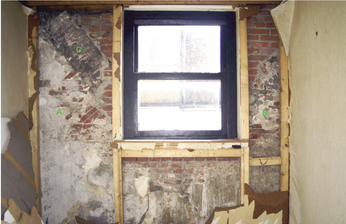
Afb. 40) De bouwsporen in de achtergevel van het rechter bouwdeel.
