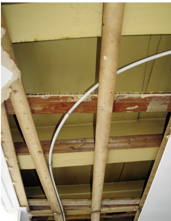
Afb. 32) Rechts: de 17de-eeuwse balklaag in de achterkamer van de verdieping in het linker bouwdeel.
