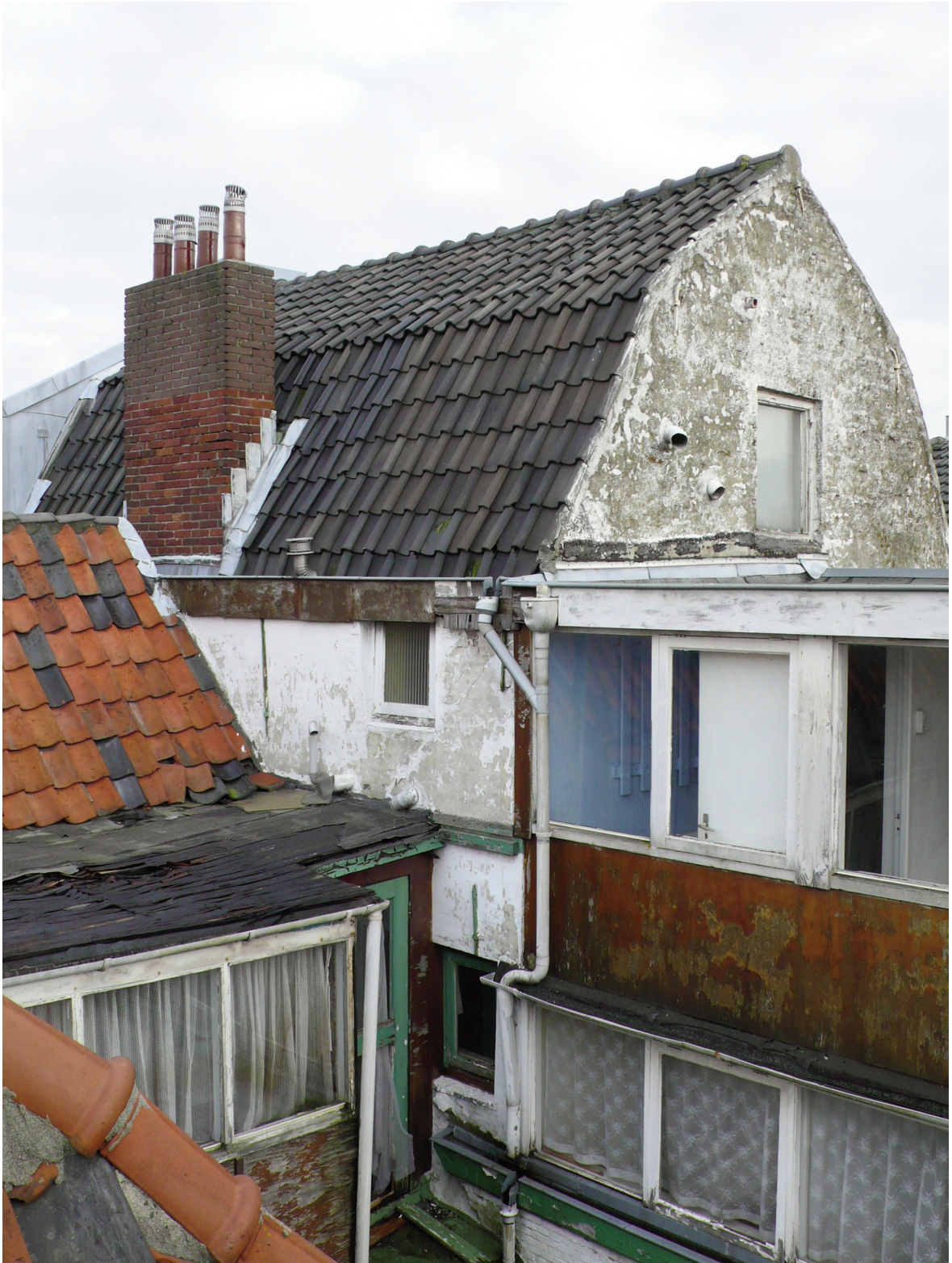
Afb. 53) De rechter zijgevel en achtergevel van het hoge deel van het pakhuis. verhoging van het voorste deel van het pakhuis (omstreeks 1900). Verder zijn in de zijgevel twee korte muurankers zichtbaar van de balklaag en een langere van de kapconstructie.
