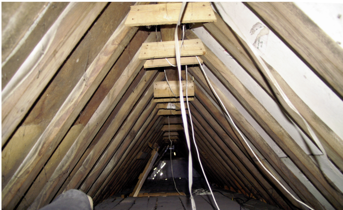
Afb. 46) De sporengespanten op de vlieringzolder in het rechter bouwdeel.
