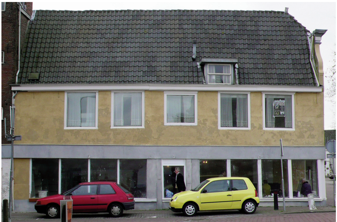
Afb. 22) De zijgevel van het linker bouwdeel aan de Venestraat.
