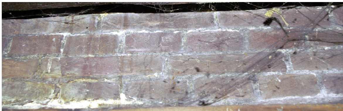
Afb. 51) De rechter zijgevel van het pakhuis: muurwerk op de begane grond.
