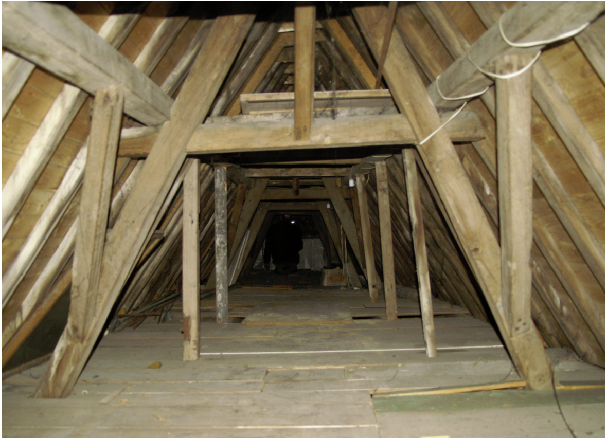
Afb. 43) De A-spanten op de vlieringzolder van het linker bouwdeel, met flieringen, sporen en schoren.
