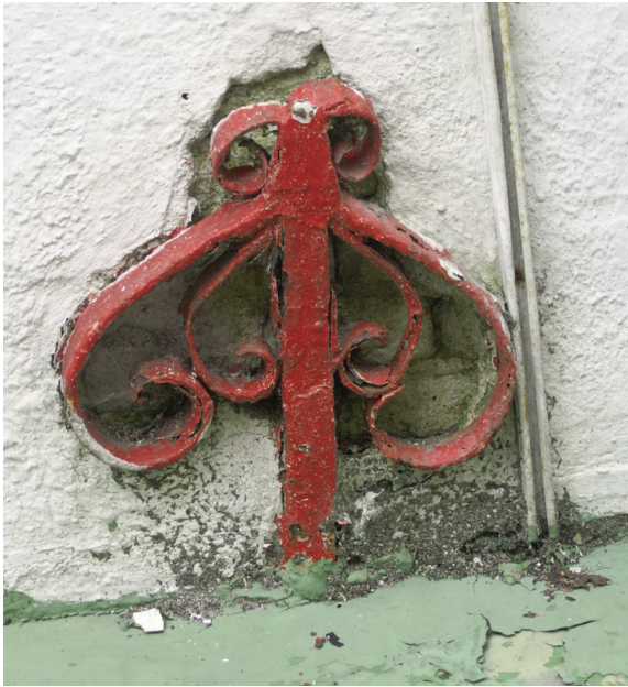
Afb. 26) Links: het sieranker op de achtergevel van het rechter bouwdeel.
