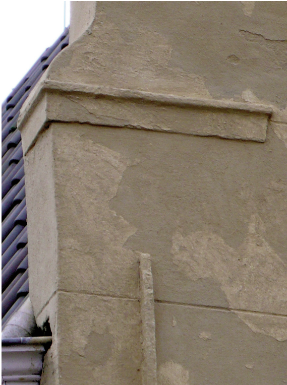
Afb. 20) Links: vermoedelijk is dit een dekplaat behorend bij een oorspronkelijke trapgevel of tuitgevel.
