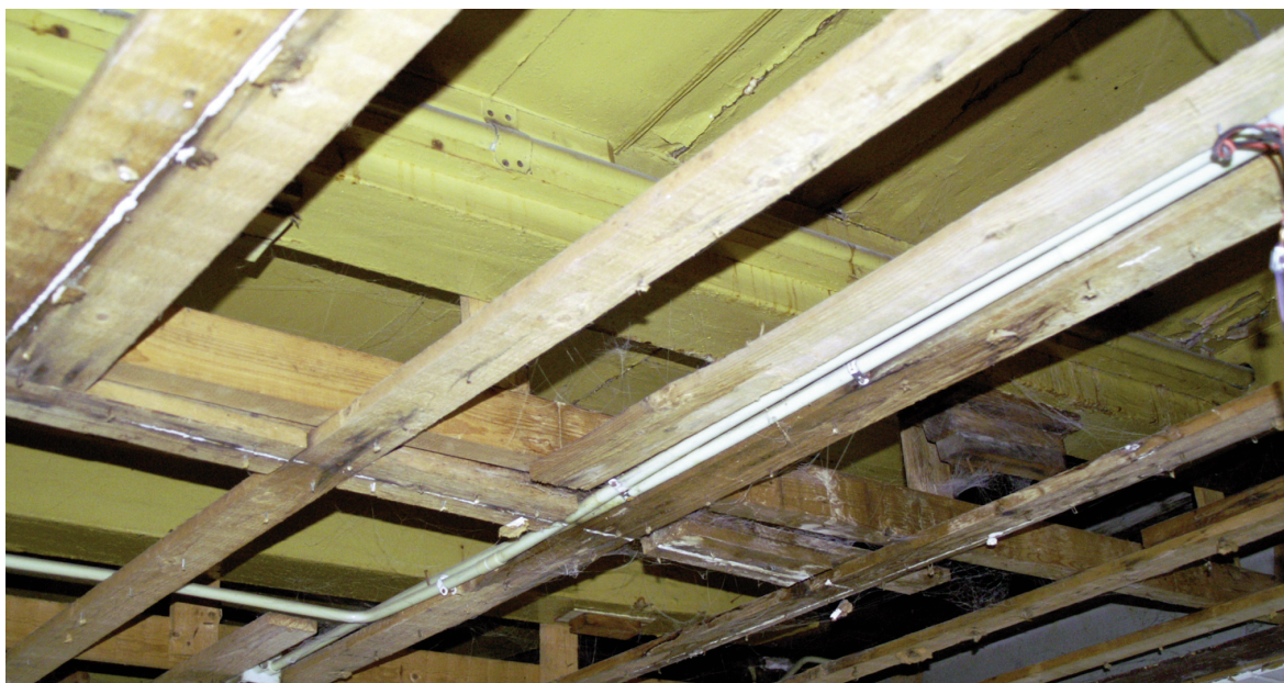
Afb. 29) De 17de-eeuwse balklaag op de begane grond in de achterste helft van het rechter bouwdeel.
