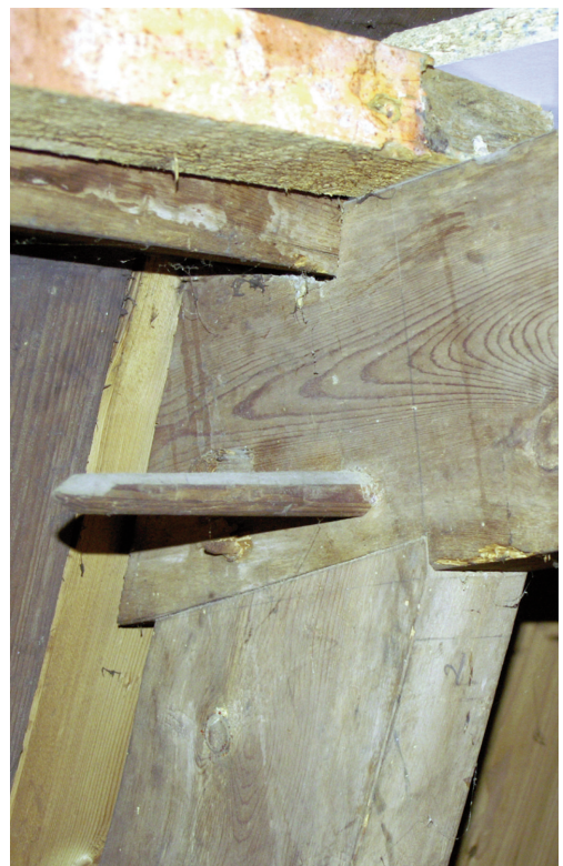
Afb. 63) Rechts: dekbalk en spantbeen zijn traditioneel bevestigd met toognagels.
