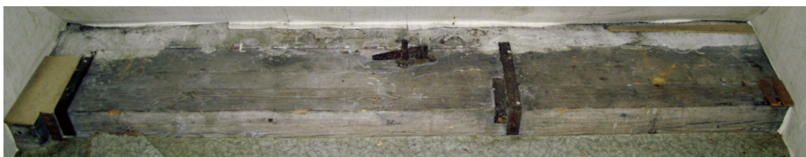
Afb. 39) De dwarsbalk langs de zijgevel waaraan enkele balken zijn gehangen.
