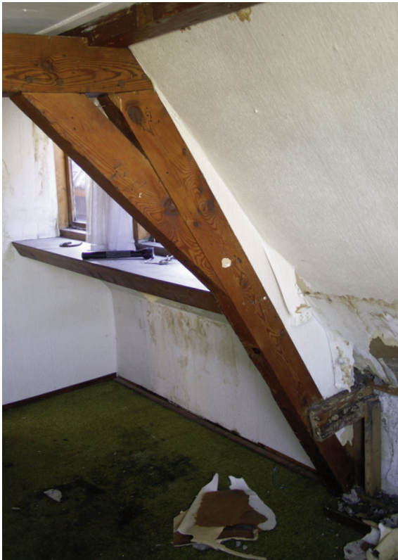
Afb. 44) Een dekbalkjuk in het rechter bouwdeel.
