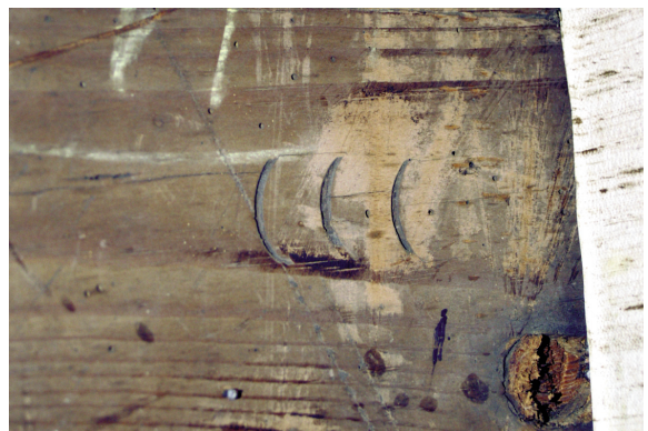
Afb. 45) De telmerken op de dekbalkjukken: boven gehakt met een beitels en onder met een guts.
