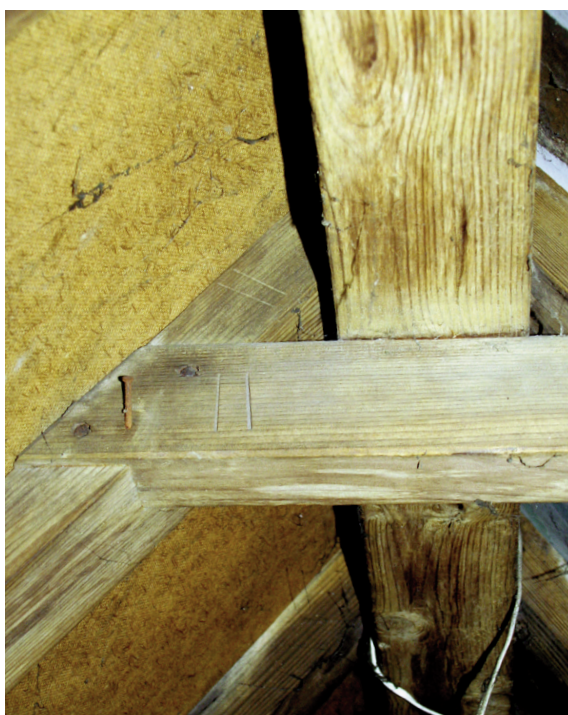
Afb. 48) Rechts: de oorspronkelijk sporen zijn bij de voorgevel nog aanwezig en blijken tevens hergebruikt in de dwarskap.
