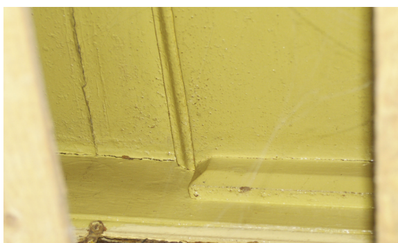
Afb. 30) Bouwsporen op de balklaag van de begane grond in het rechter bouwdeel.
