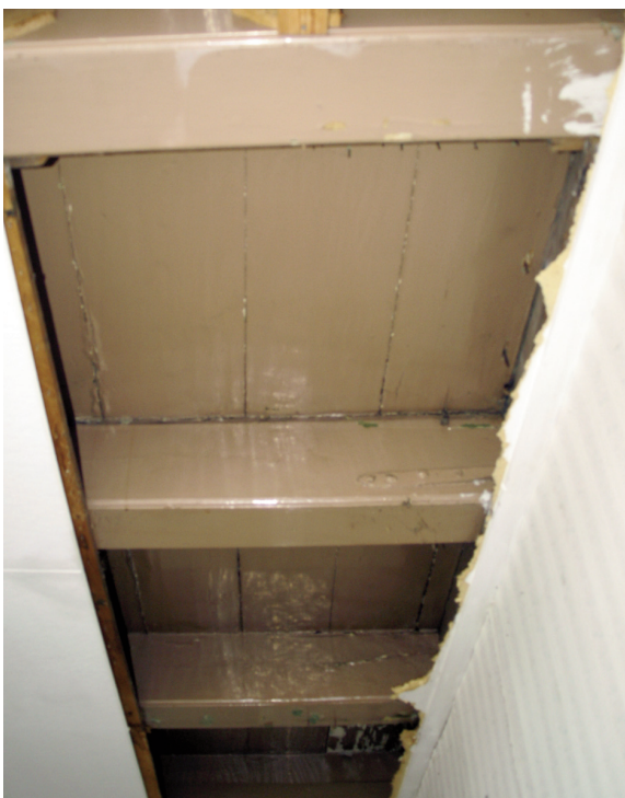
Afb. 36) Rechts: de raveling in de achterkamer op de verdieping van het rechter bouwdeel.
