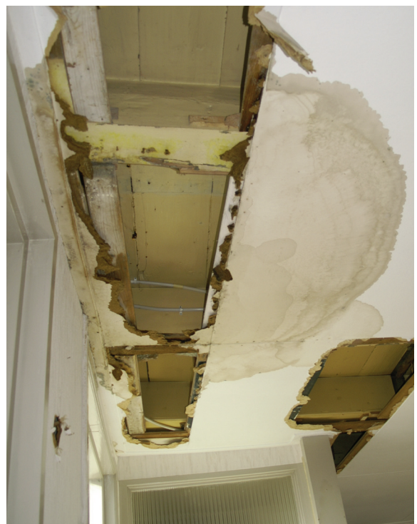
Afb. 32) Rechts: de 17de-eeuwse balklaag in de achterkamer van de verdieping in het linker bouwdeel.
