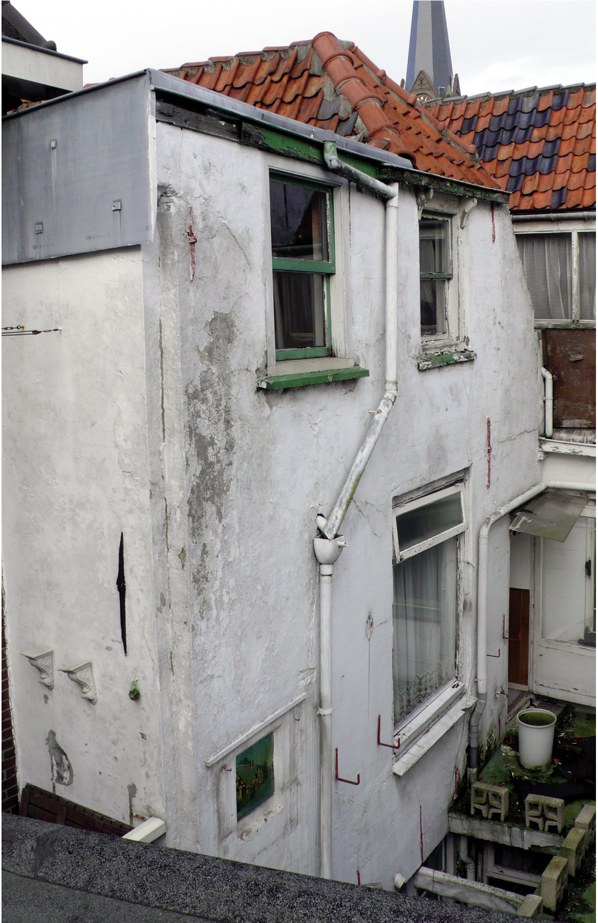
Afb. 25) De rechter zijgevel en de achtergevel van het rechter bouwdeel.
