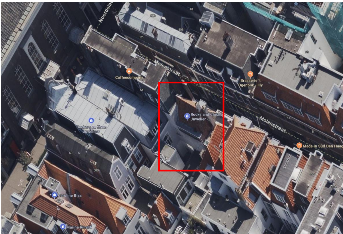
Luchtfoto van de bebouwing aan het Noordeinde (links) en Molenstraat (rechts), gezien vanuit het noordwesten (Bing maps). Het pand Molenstraat 3/ 3A is omkaderd. Duidelijk herkenbaar is de gepleisterde drielaags achtergevel, evenals de dakkapel over de volle breedte van het pand.
