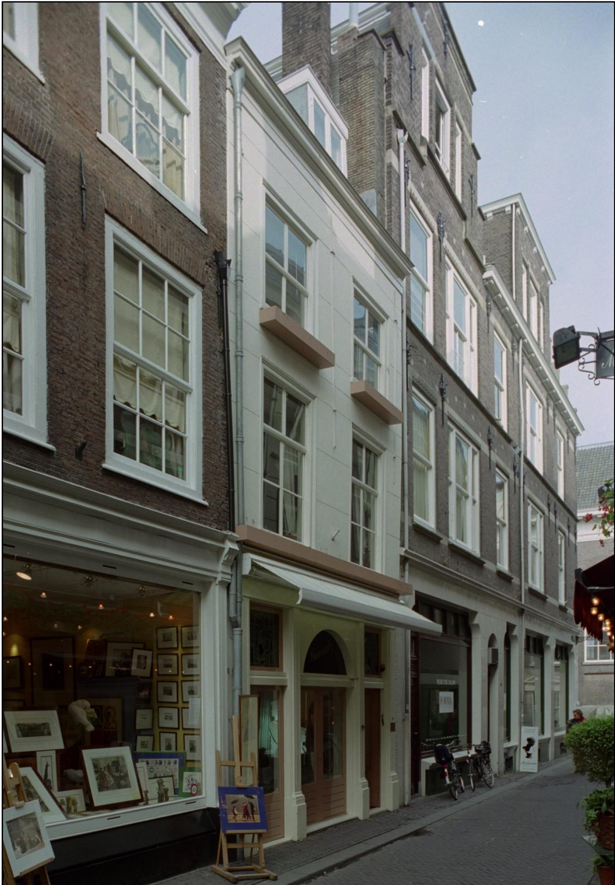
De voorgevel van Molenstraat 3 op 13 oktober 1998, foto van Paul Lunenberg van de Dienst Stadsontwikkeling (HGA beeldbank, nr. 6984). Op het bovenlicht staat de naam 'Biarritz'.
