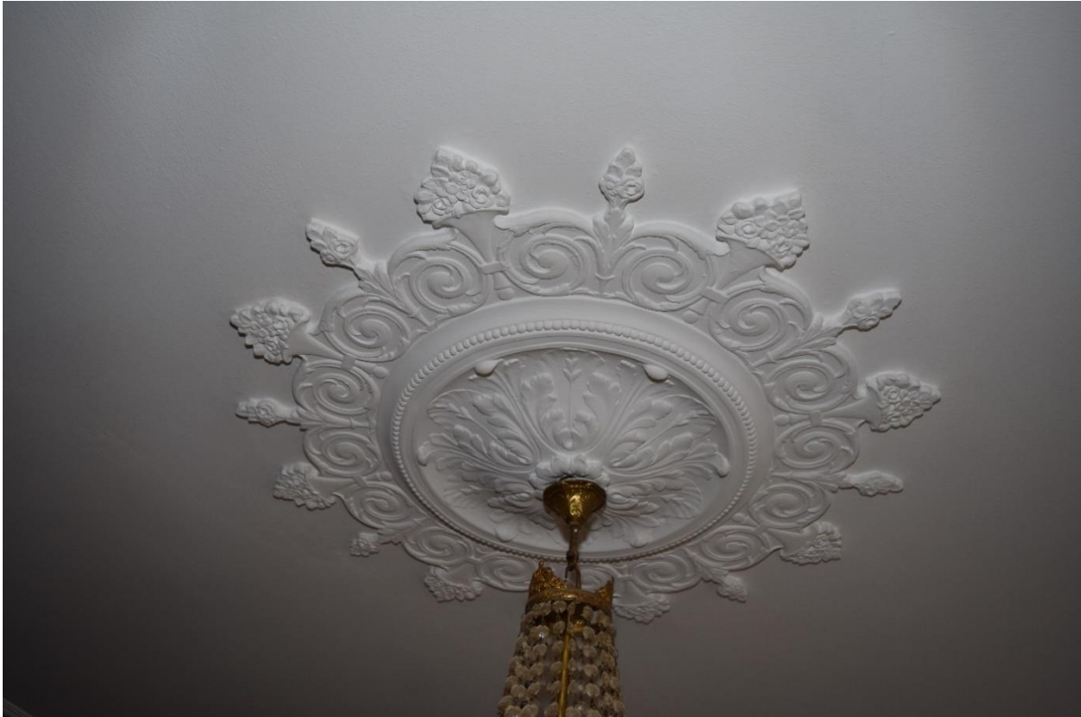
De middendecoratie van het stucplafond op de eerste verdieping.
