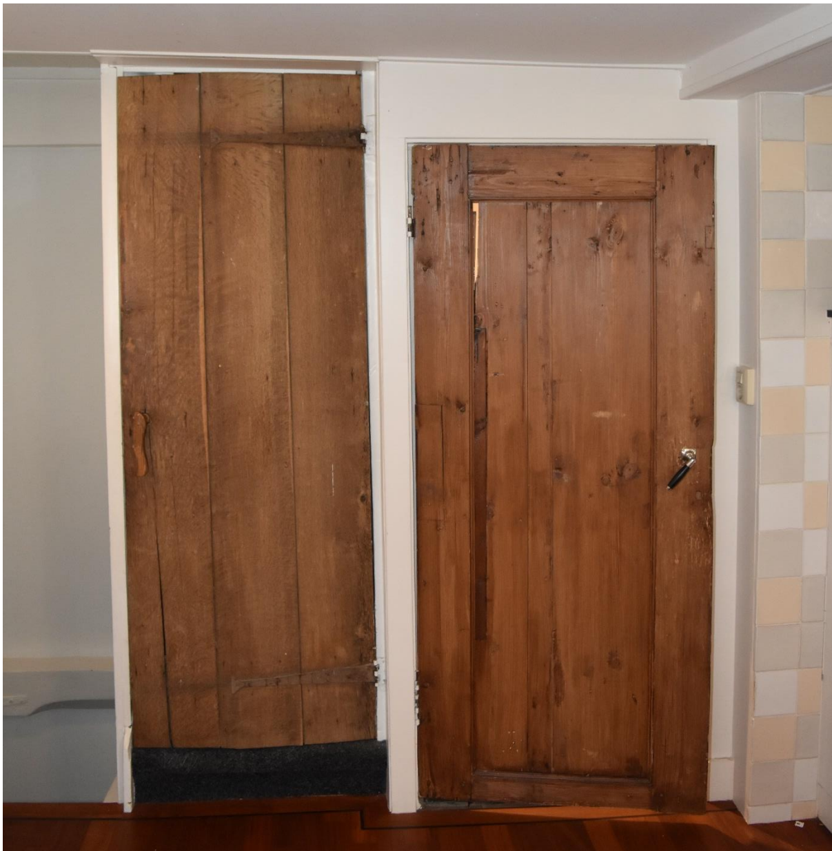
De twee herplaatste deuren op de tweede verdieping. Links is een eikenhouten strokendeur herkenbaar (17 de of 18 de eeuw) en rechts een naaldhouten paneel deur (19 de eeuw). De eikenhouten deur is op maat gezaagd. De naaldhouten deur is gekeerd en ingekort.
