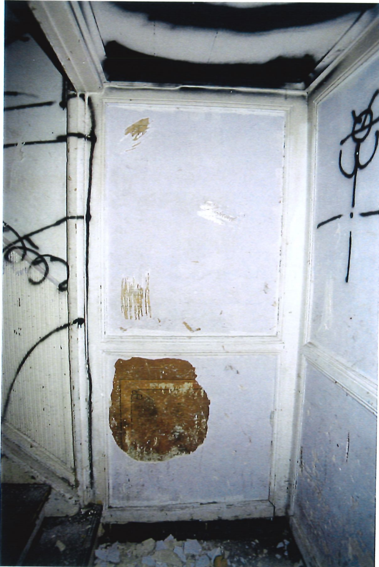
Afb. 16) Het deel van het trappenhuis dat leidt naar het souterrain is bij de entree vanaf de Paviljoensgracht voorzien van een betimmering van elkaar kruisende geprofileerde latten, die dateert uit het einde van de 19de of het begin van de 20ste eeuw. Deze betimmering is echter over een oudere, vermoedelijk begin 19de-eeuwse schildering aangebracht, die een houtkleurige paneelverdeling weergeeft.
