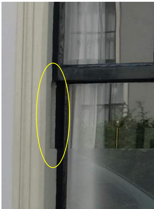
Afbeelding 48 (linksboven) – Inkeping in het kozijn van nr. 8 ten behoeve van het naar beneden schuivend bovenlicht.
