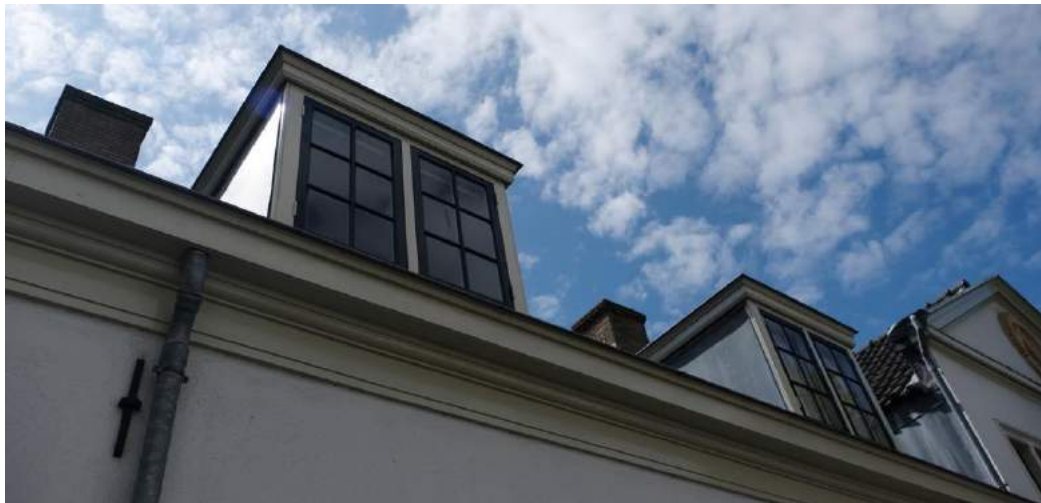
Afbeelding 59 – Dakkapellen op de woningen 8 en 10.
