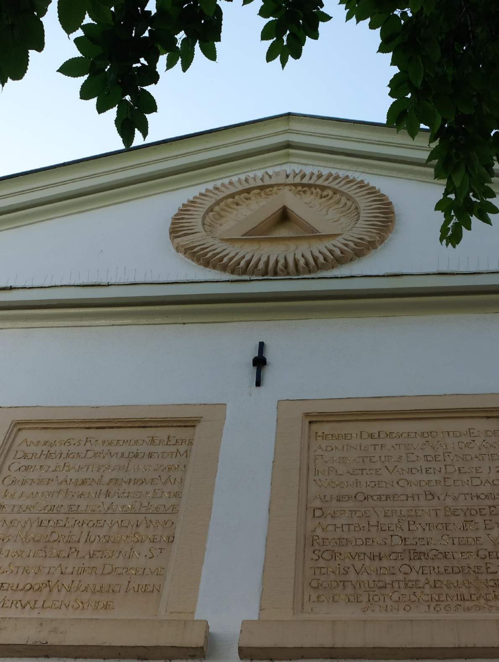
Afbeelding 68 – Detail van de gevel Hoge Zand 12 – 14.
