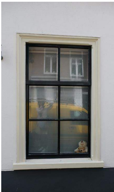
Afbeelding 47 (rechtsonder) – Detail van de gebiljoende stijlen en bovendorpel van de kozijnen in de voorgevel van het bouwblok.
