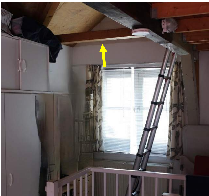
Afbeelding 32 – Ook de dekbalk van de opgemetselde gevel is vervangen (gele pijl).
