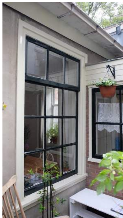
Afbeelding 48 (linksboven) – Inkeping in het kozijn van nr. 8 ten behoeve van het naar beneden schuivend bovenlicht.
