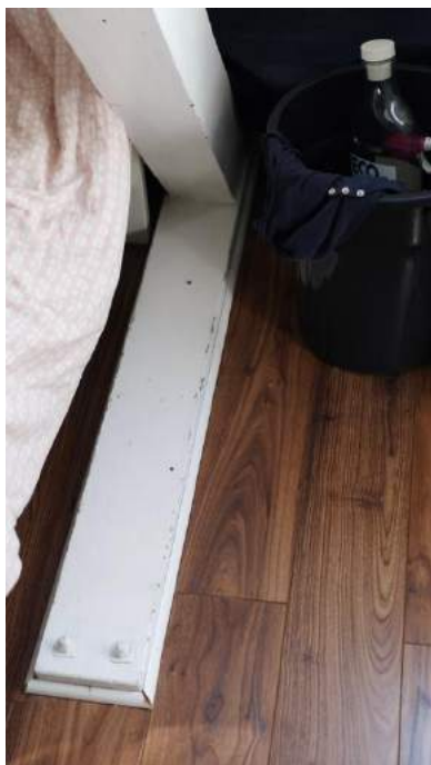
Afbeelding 22 (linksboven) – De slof onder het spantbeen steekt enige centimeters boven de vloer uit.
