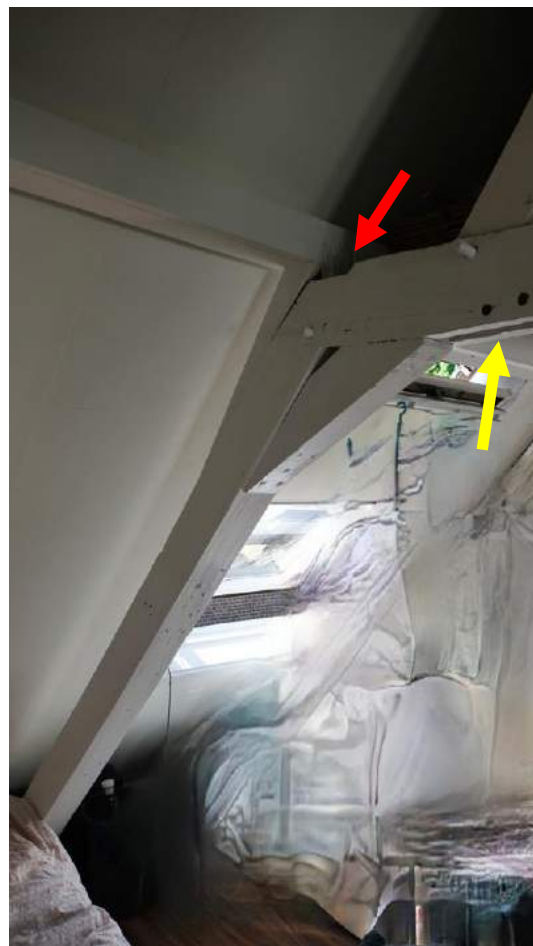
Afbeelding 18 (links) – De opgemetselde gevel van nummer 12 leidt ertoe dat er gebruik is gemaakt van een muurstijl in plaats van een spantbeen.
