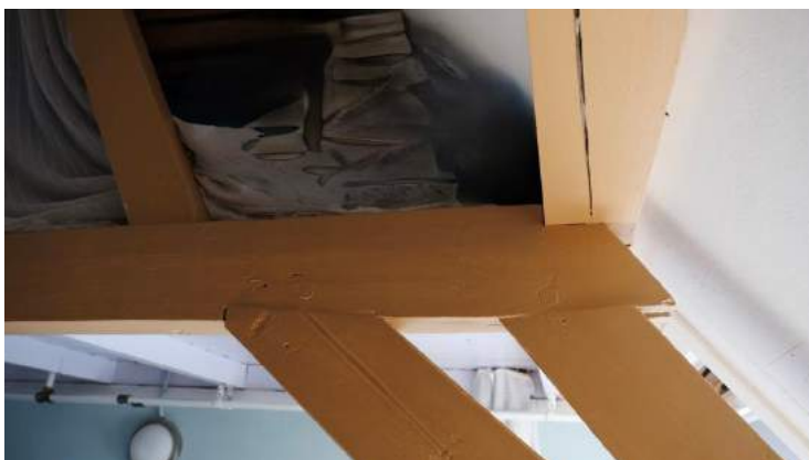
Afbeelding 36 (onder) – Dekbalkspant, spantbeen, schaarspant en fliering achtergevelzijde. Ook hier zijn de penverbindingen goed zichtbaar.
