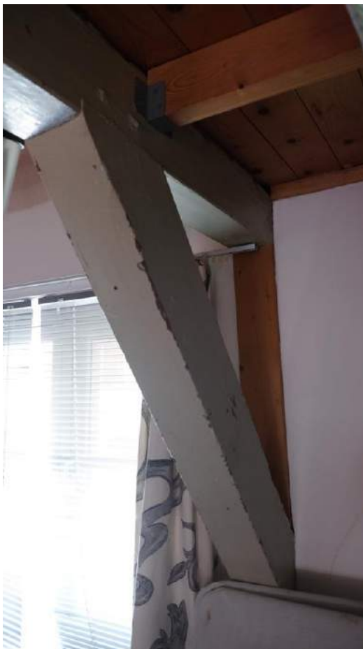
Afbeelding 25 (linksboven) – De muurstijl en het korbelaar ondersteunen de dekbalk ter plaatse van de opgehoogde voorgevel. Zichtbaar is de in 1991 ingebrachte vliering.
