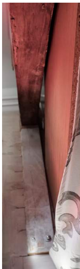
Afbeelding 28 (linksboven) – De slof onder het spantbeen ter plaatse van de achtergevel.
