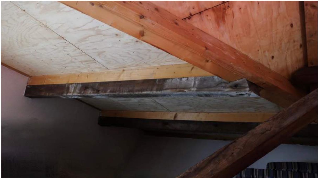
Afbeelding 31 (onder) – De aanpassingen in de flieren en de ondersteunende gordingen van de opgemetselde voorgevel zijn duidelijk zichtbaar als toevoeging.
