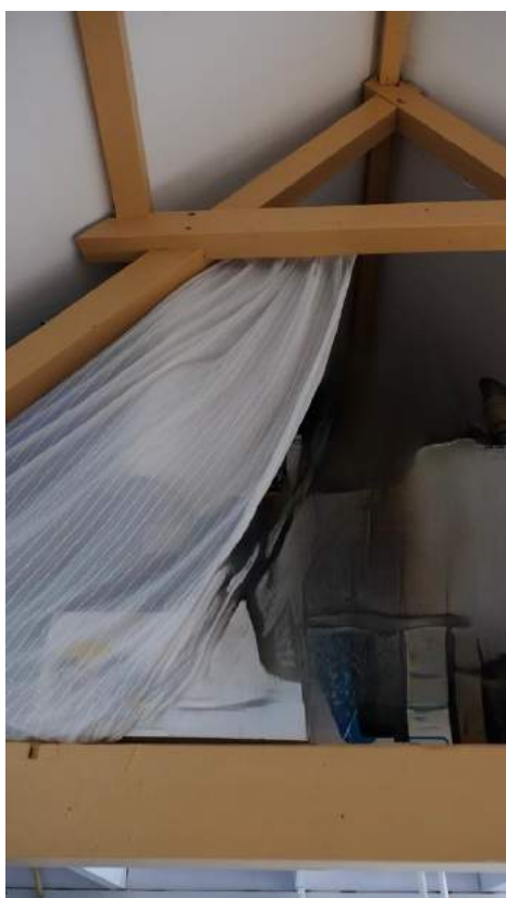
Afbeelding 38 (linksboven) – Zicht op het schaarspant. De schetsplaat ter plaatse van de nokgording ontbreekt. Afbeelding 39 (linksboven) – De slof van jong hout aan de voorgevelzijde.
