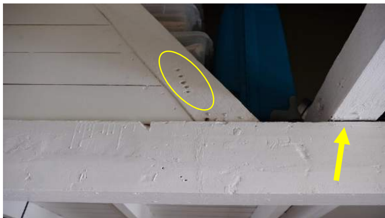
Afbeelding 22 (linksboven) – De slof onder het spantbeen steekt enige centimeters boven de vloer uit.
