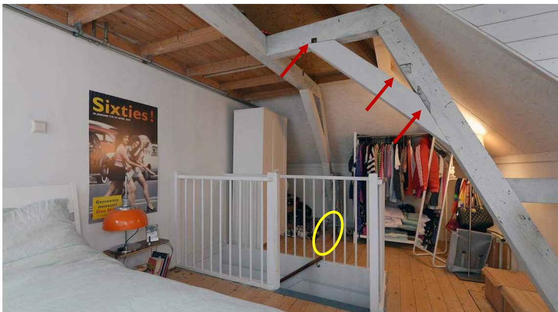
Afbeelding 14 (vorige pagina) - Dekbalkspant van woning nummer 2. Geel omcirkeld de slof onder de spantbenen (foto Stadsherstel Den Haag). In het spantbeen aan de zijgevelzijde zijn littekens zichtbaar in het hout, die vermoedelijk verwijzen naar de constructie van de oorspronkelijke trap met een doorlopende spil (rode pijlen),
