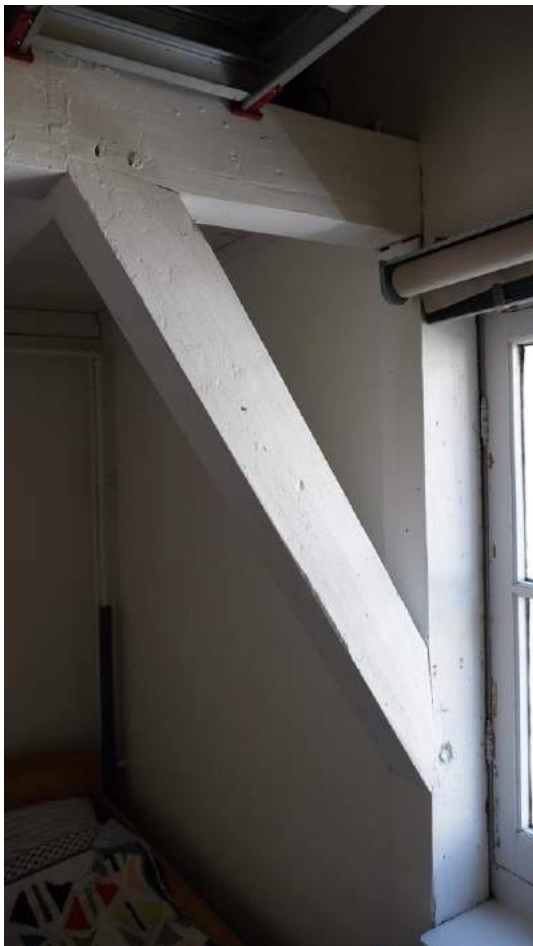
Afbeelding 18 (links) – De opgemetselde gevel van nummer 12 leidt ertoe dat er gebruik is gemaakt van een muurstijl in plaats van een spantbeen.
