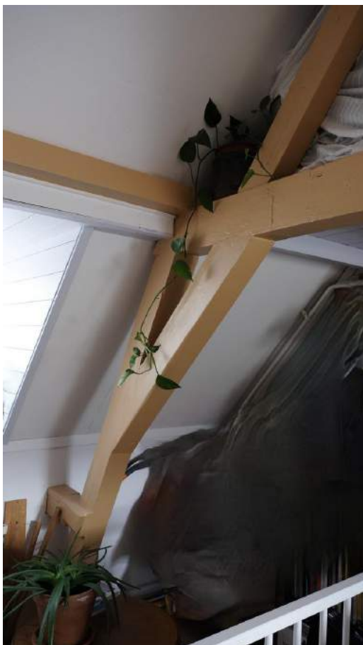
Afbeelding 33 (links) – Dekbalkspant en schaarspant voorgevelzijde.
