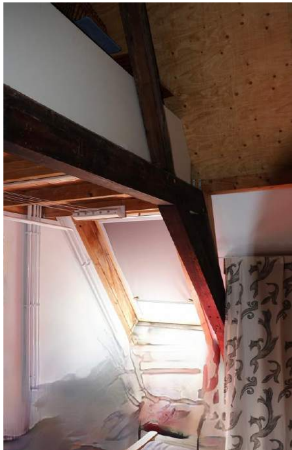
Afbeelding 25 (linksboven) – De muurstijl en het korbelaar ondersteunen de dekbalk ter plaatse van de opgehoogde voorgevel. Zichtbaar is de in 1991 ingebrachte vliering.
