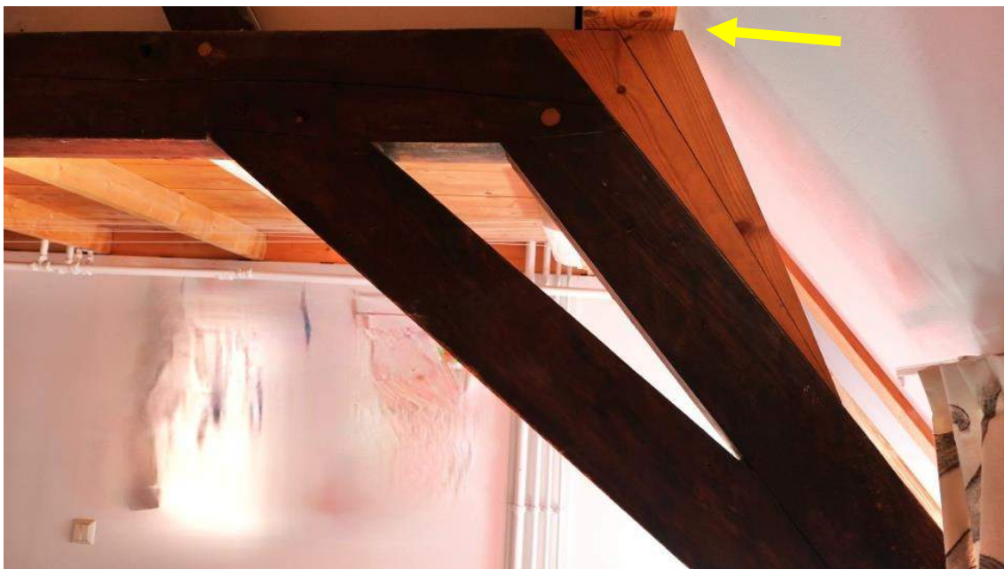
Afbeelding 27 (boven) – De vernieuwde fliering wordt gedragen door een houten scheg of driehoekig blok dat tegen het spantbeen is bevestigd (gele pijl). Enkele pennen zijn vervangen.
