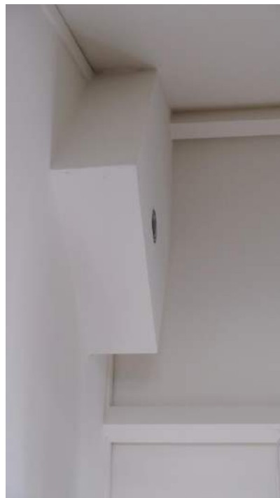
Afbeelding 63 (linksboven) – Interieur vlak voor de renovatie van 1991 (Haags gemeentearchief, vervaardiger P.G. Kempff). Afbeelding 64 (rechtsboven) – Restant van het rookkanaal op de zolderverdieping van de woningen. Op deze foto het rookkanaal van nummer 12.
