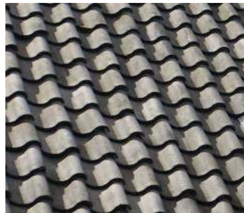
Afbeelding 43 (rechts) – De gesmoorde Opnieuw Verbeterde Holle pannen op het dak van de Geefhuisjes.
