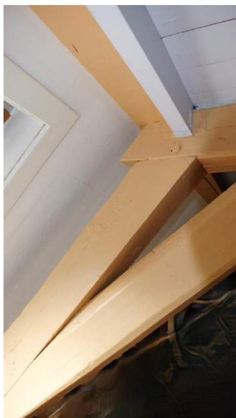
Afbeelding 34 (rechts) – Dekbalkspant en spantbeen schaarspant achtergevelzijde. De fliering ligt op zijn oorspronkelijke positie in een inkeping van de dekbalk (gele pijl).
