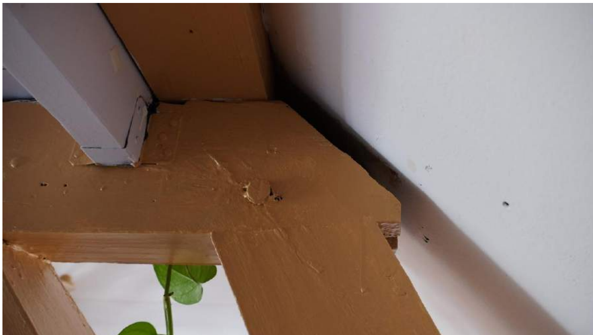
Afbeelding 37 (onder) – Aansluiting spantbeen, dekbalk en fliering aan de voorgevelzijde. De witte balk die haaks op de dakbalk staat is van de in 1991 aangebrachte vliering.
