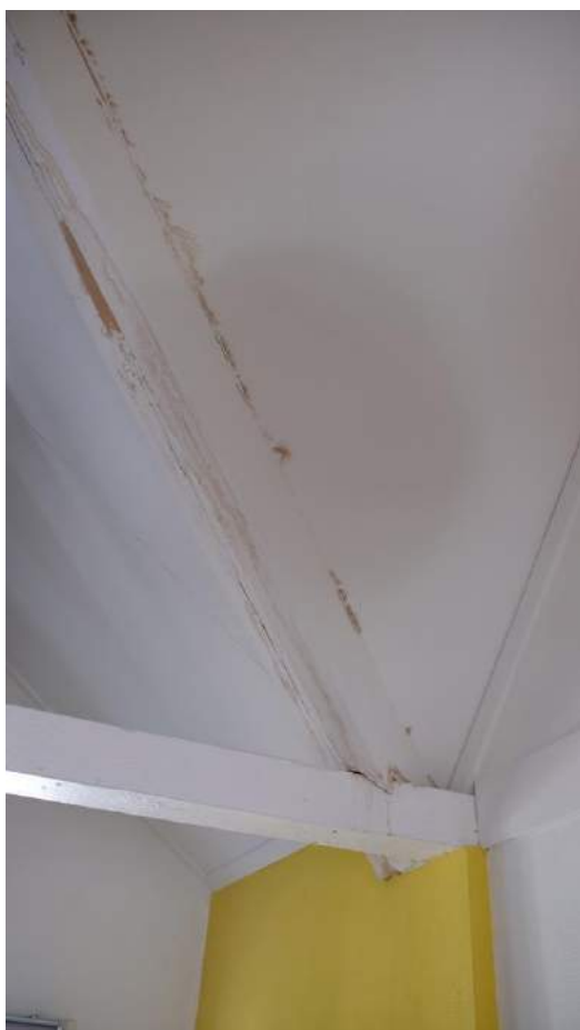
Afbeelding 24 (onder) – Hoekkeper van de opgemetselde geveltop en de in de muur ingelegde dekbalk.
