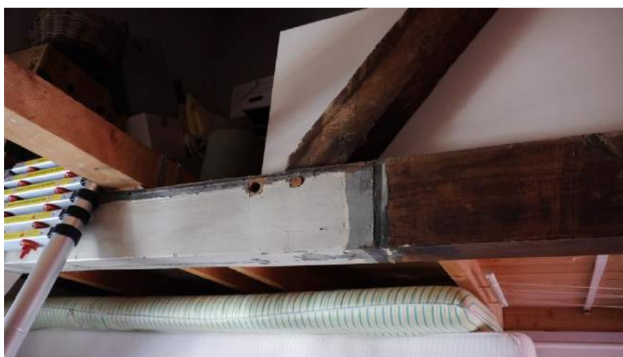
Afbeelding 28 (linksboven) – De slof onder het spantbeen ter plaatse van de achtergevel.
