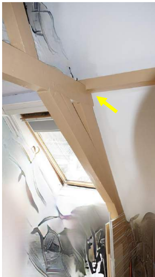
Afbeelding 34 (rechts) – Dekbalkspant en spantbeen schaarspant achtergevelzijde. De fliering ligt op zijn oorspronkelijke positie in een inkeping van de dekbalk (gele pijl).
