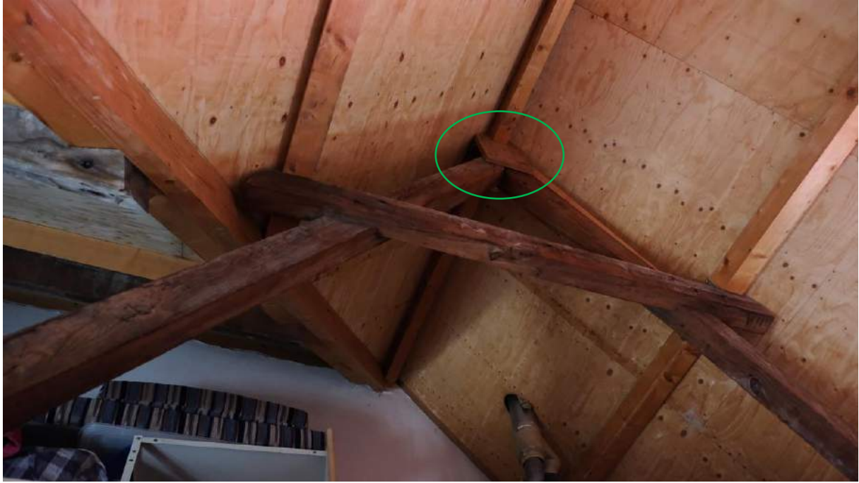
Afbeelding 30 (boven) – De overkepte balk ondersteunt de nieuwe flieren en nokgording. De oude schetsplaat is vervangen door een groter exemplaar (groene cirkel).
