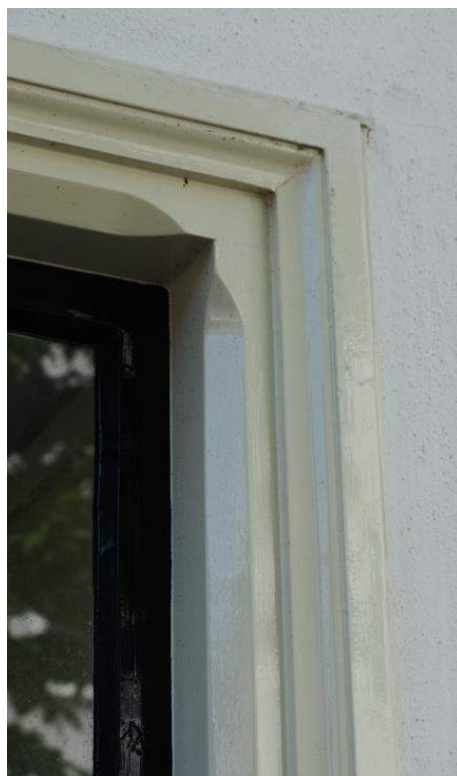
Afbeelding 47 (rechtsonder) – Detail van de gebiljoende stijlen en bovendorpel van de kozijnen in de voorgevel van het bouwblok.
