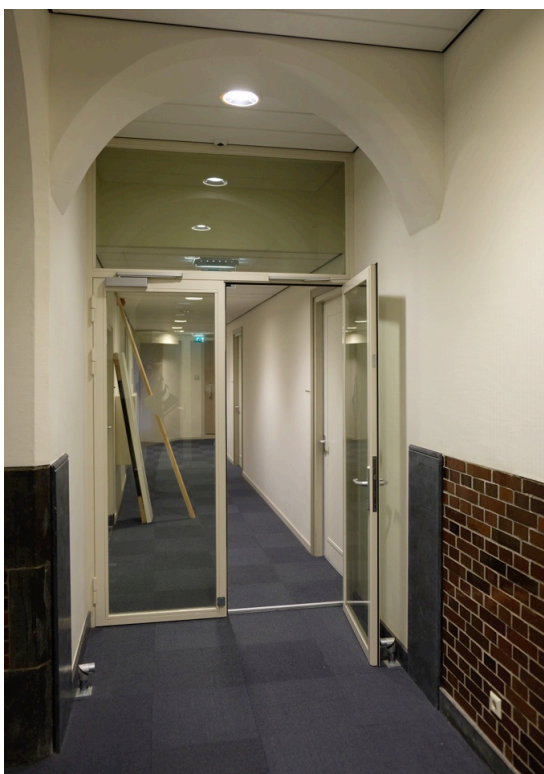
Afbeelding 51 (links) gang op de eerste bouwlaag gezien richting het oosten. Direct in beeld de moderne pilasters met een erboven gelegen, gelijktijdig aangebrachte toog.
