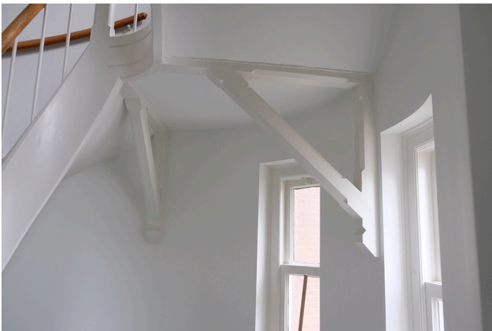
Afbeelding 48 (onder) Korbelen die de trap ondersteunen.
