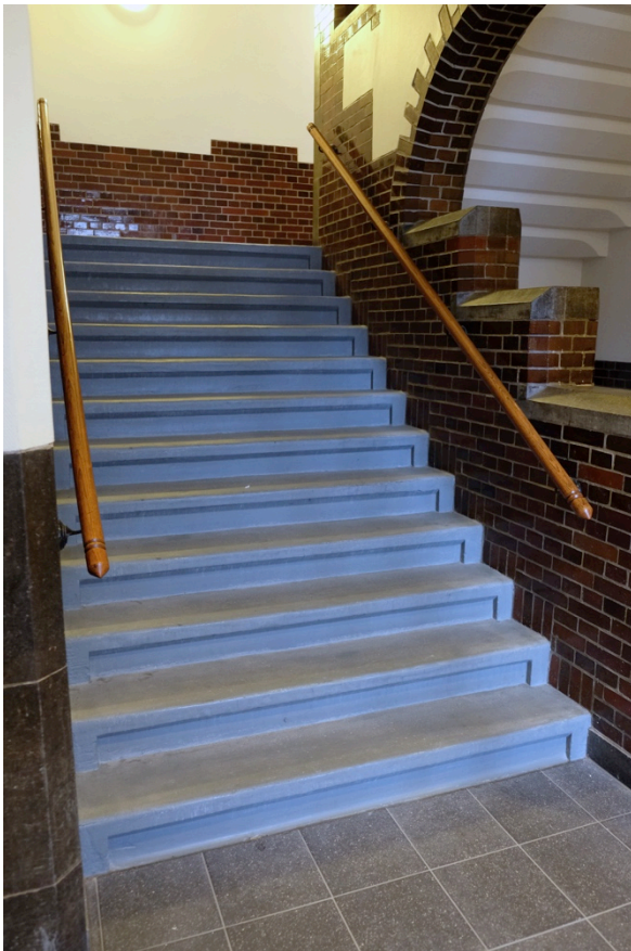
Afbeelding 43 Centrale trap vanaf de hal gezien.
