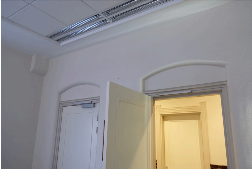
Afbeelding 42 Deurnissen in de ruimte T. De beide deuren waren oorspronkelijk van elkaar gescheiden door een muur.
