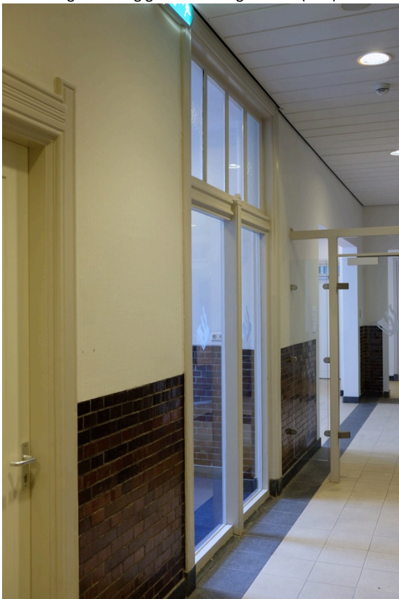
Afbeelding 37 Gang gezien richting westen (ri. C)
