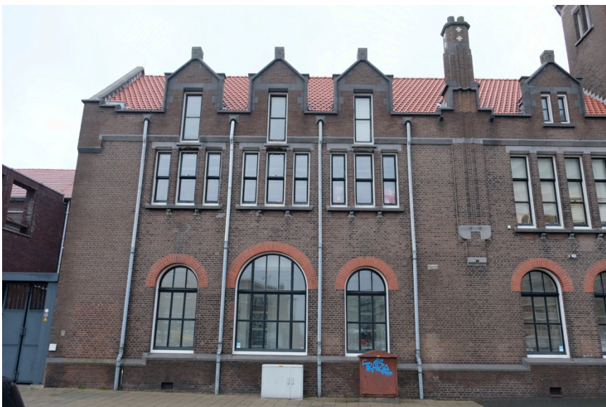
Afbeelding 28 (rechtsonder) Rookkanaal in de gevel van de Duinstraat
