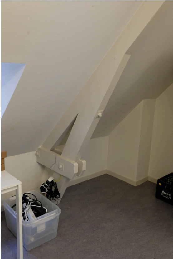
Afbeelding 60 (links boven) Blokkeel en karpoot van het spant.
