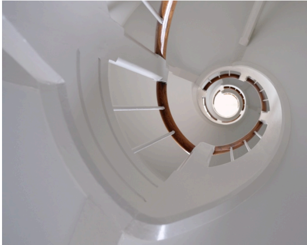
Afbeelding 49 Kenmerkende 'slakkenhuis'-vorm in het hart van de Engelse trap.
