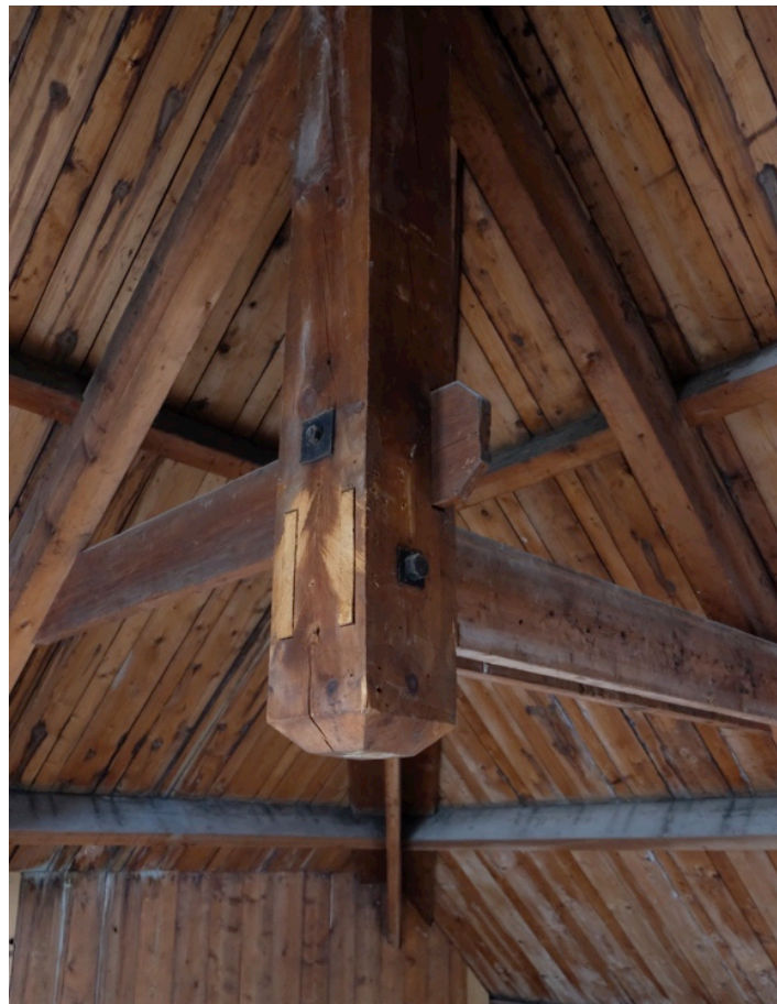
Afbeelding 69 (onder) Hoekconstructie van de kap.
