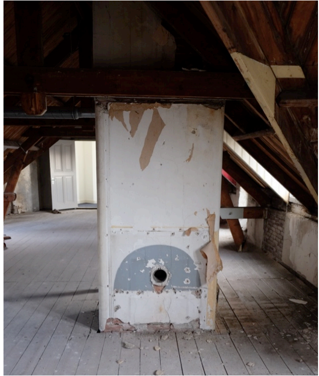
Afbeelding 68 (links boven) Rookkanaal met kachelopening en verfesten op de balken die verwijzen naar een kamerindeling.
