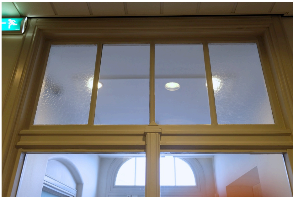
Afbeelding 39 (Boven) Pui tussen entreehal en gang (bovenlicht)
