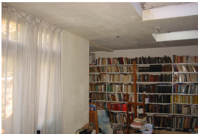
89. 105A: achteraanbouw (foto Stadsherstel, ca. 2003).
