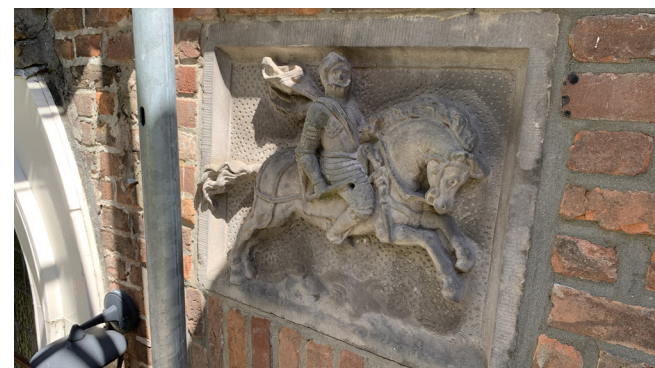
41. Gevelsteen in voorgevel 105G.
