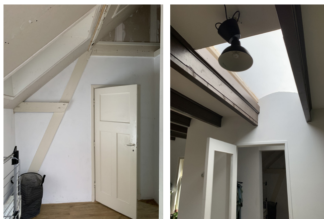
203. Spant in 105F. En balklaag met lichtstraat er tussen in 105G.
