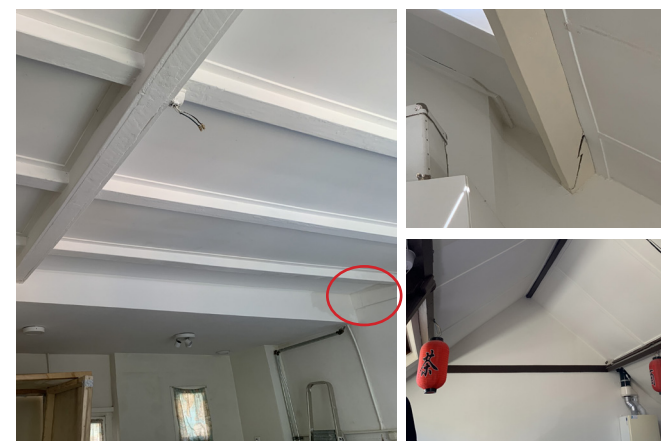
18. Balklaag in 105B. Haaklas in gording 105C en hanenbalk in muur 105E.
