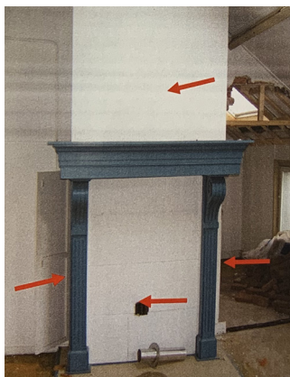
78. Schouw 105E verd. (rapport tbv asbestsanering, ca. 2003).
