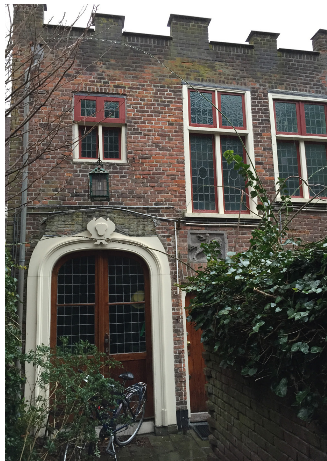
161. De voorgevel van 105G (foto Stadsherstel).
