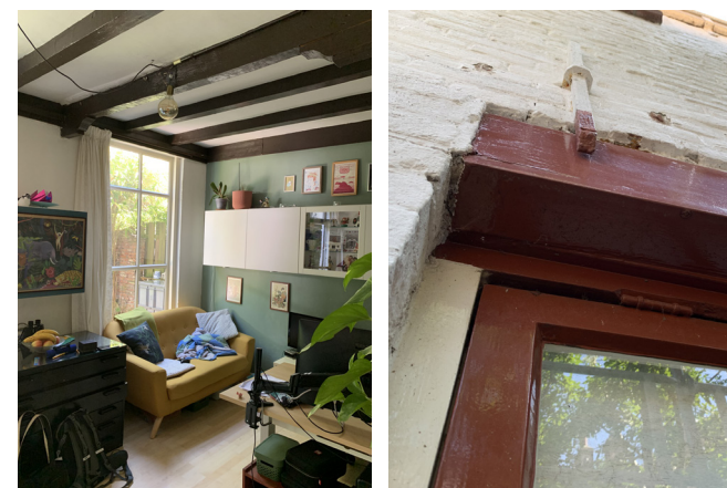
198. Balklaag in 105E. En gevelankers in de voorgevel van 105A.
