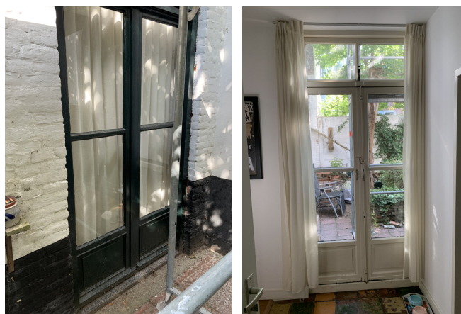
179. De dubbele tuindeuren van buiten en binnen (hier van 105F).
