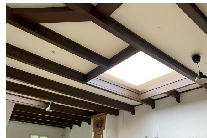
205. Balklaag op de verdieping van 105G.
