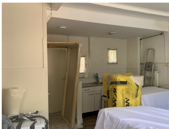
215. 105B: richting de voorgevel.
