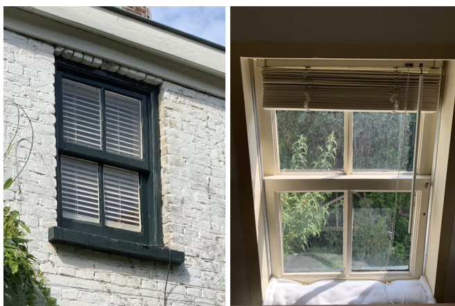
182. Vier-ruits schuiframen op de verdieping van buiten en binnen (105C).
