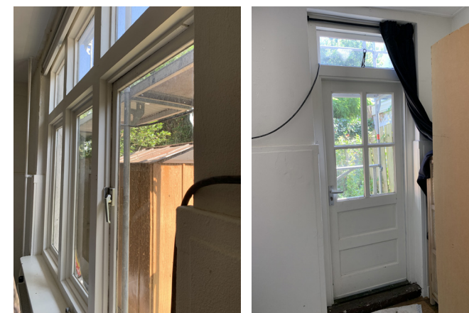
186. Driedelig venster met bovenlichten en de gewijzigde deur in 105B.
