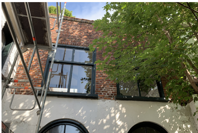
176. Het bovenste deel van de rechter zijgevel van de aanbouw van 105G.
