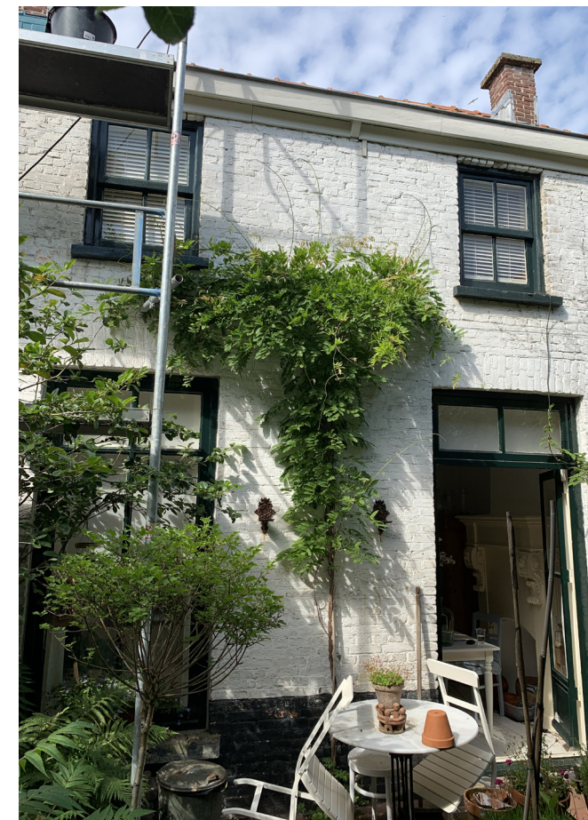
180. Achtergevel 105C, representatief voor de achtergevels van de huisjes.
