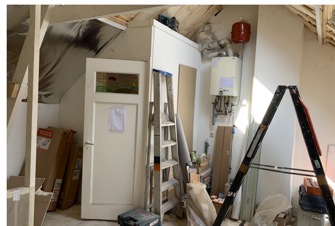
218. 105B: de verdieping/zolder richting de badkamer.
