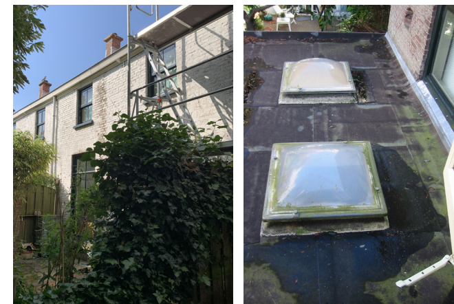
191. De schoorstenen. En het platte dak van de aanbouw 105A (Stadsherstel).
