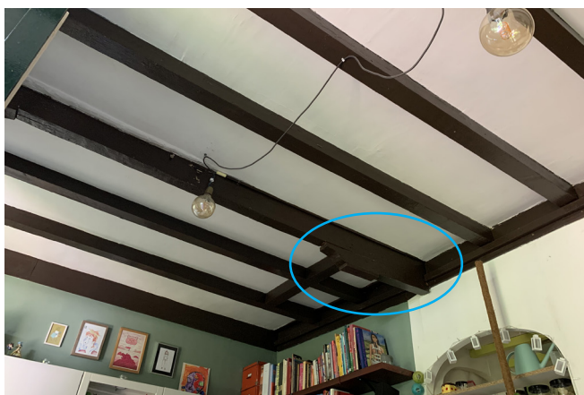
196. Balklaag in 105E met sleutelstuk onder moerbalk in de blauwe cirkel.
