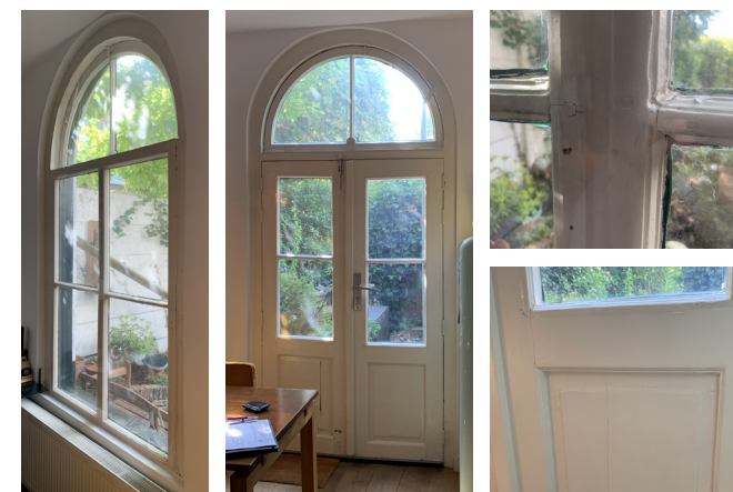
175. Binnenkant van het raam en de deuren in de zijgevel van 105G.
