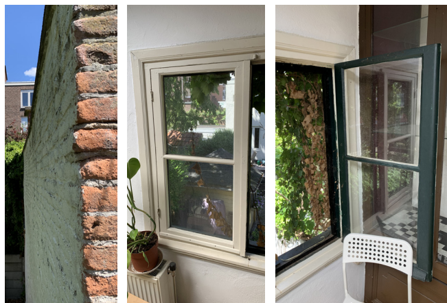
172. Rechter zijgevel van 105G. En het venster in deze gevel vanuit binnen.
