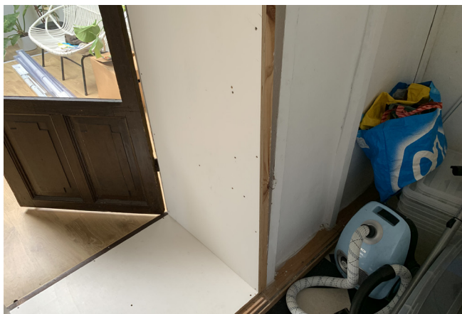
271. 105G: de opslagruimte achter de kast.
