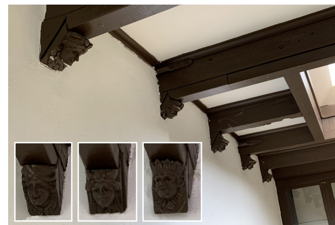
268. 105G: hoofdjes onder de balken (bouwfragmenten).
