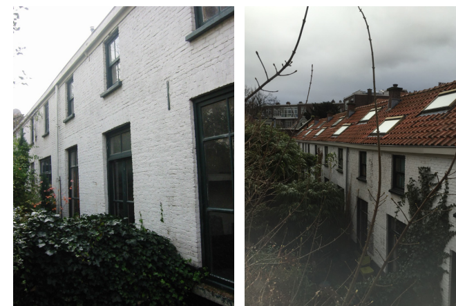
111. Achtergevels en dak (foto's Stadsherstel, ca. 2003).
