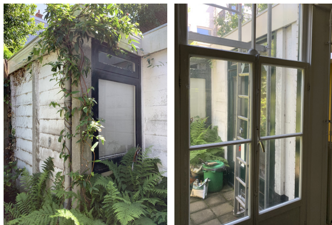
178. De linker zijgevel van de achteraanbouw van 105A.
