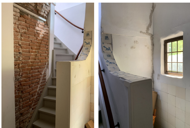
254. 105G: de trap naar boven en de kleine ruimte naast de trap.
