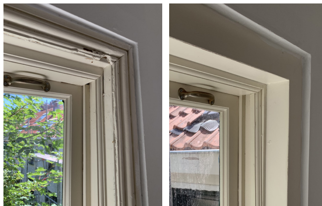
46. Verdieping zijgevel achteraanbouw; een venster met geprofileerde omlijsting en de ander zonder.
