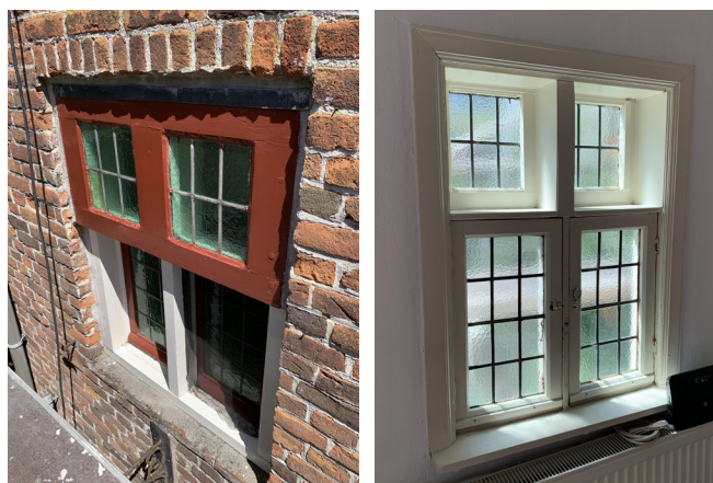
167. Klein kruiskozijn op de verdieping van 105G.
