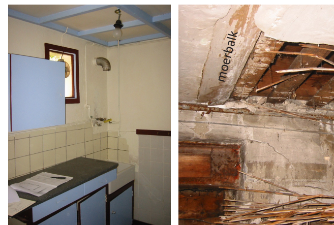
94. 105B: keuken en plafond boven keuken (foto's Stadsherstel, ca. 2003).
