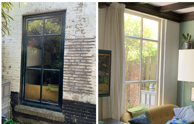
181. Zes-ruits raam van buiten en binnen (hier van 105E, let op: omlijsting buiten is een uitzondering).
