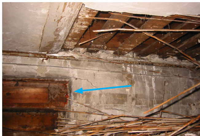
22. Stalen latei boven brede doorgang in voorgevel 105B (foto Stadsherstel).
