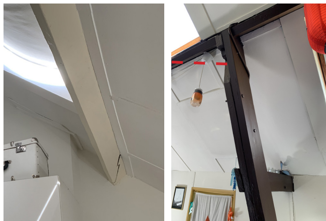
202. Haaklas in doorlopende gording. En spant in 105E.
