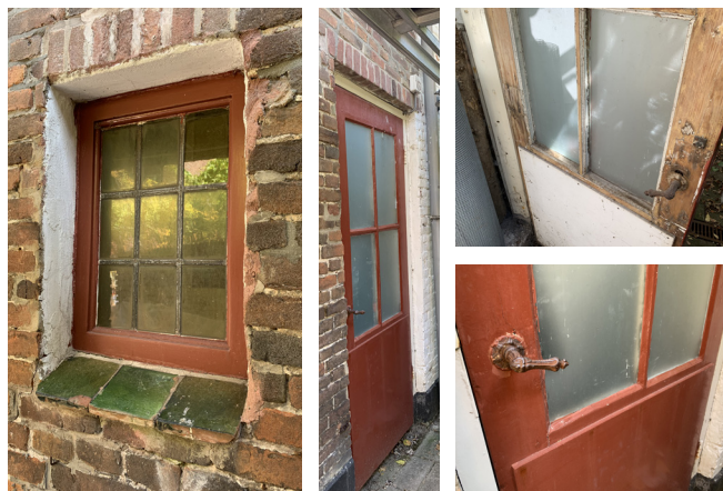
166. Raampje en deur rechts in de voorgevel van 105G.
