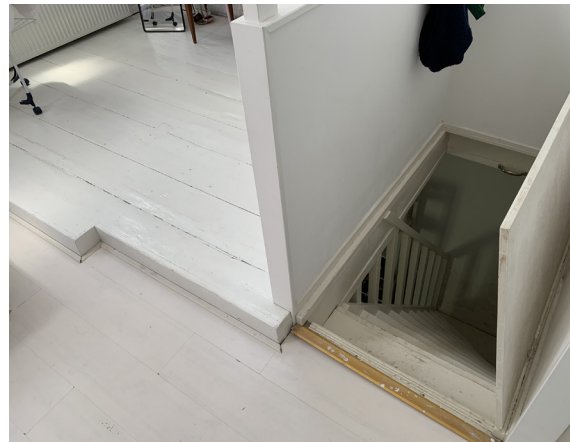
208. 105A: detail verhoogde zoldervloer en de trap naar beneden.
