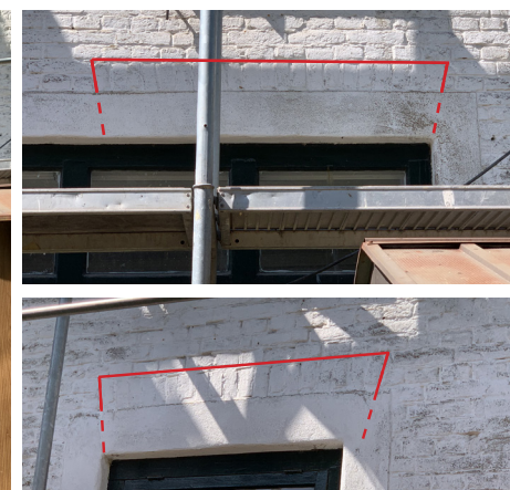
30. Oorspronkelijke strekken nog zichtbaar.
