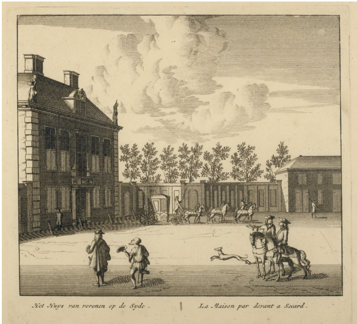
Afb. 4. 'Het Huys van vorenen op de Syde - La Maison par devant a Secard'. Het landhuis met rechts het koetshuis omstreeks 1725. Het gebouw heeft hier een omgaand schilddak. Als de gevel symmetrisch was opgebouwd was er oorspronkelijke sprake van drie dubbele toegangsdeuren voor rijtuigstallingen. Merkwaardig is de hoge zolderverdieping [Beeldbank Archief Delft]
