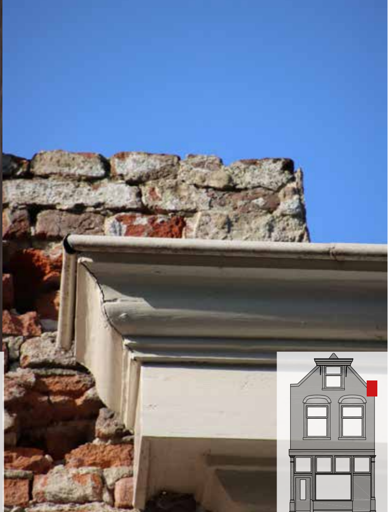
BOVEN: Een enkele klezoor in de koppenlaag ONDER: Geen eindplossing meer bij de belending rechts
