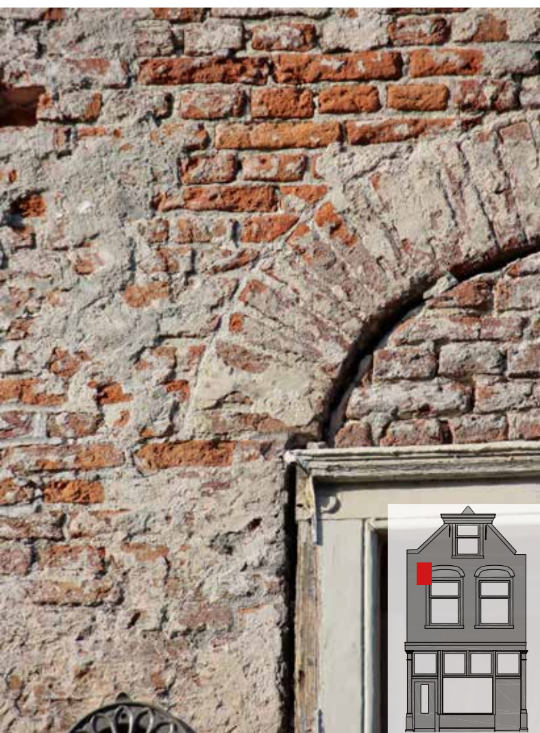
BOVEN: Hak- en herstelwerk (geen eindplossing) ONDER: Detail hoek korfboog
