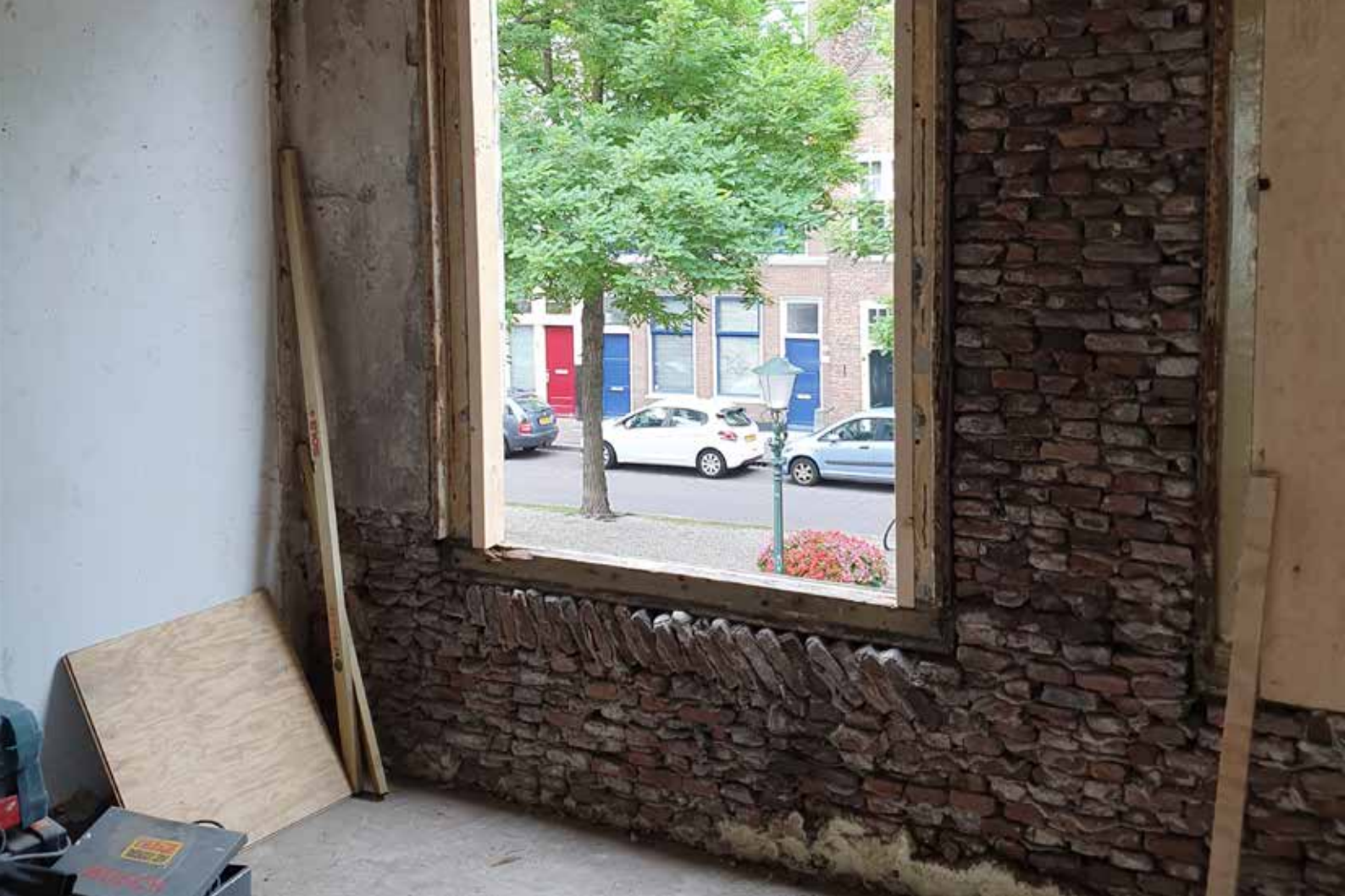
28 AFBEELDING: De kozijnen op de eerste verdieping
