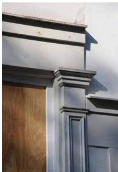
De kroonlijst is inmiddels vervangen door een eenvoudig boeideel.
