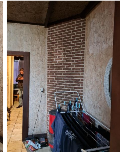
Niet oorspronkelijk rookkanaal
