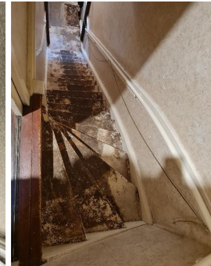
De trap is in 1933 vernieuwd.
