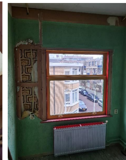
Kleine slaapkamer met voorzetwand. Oorspronkelijke vensterbank.
