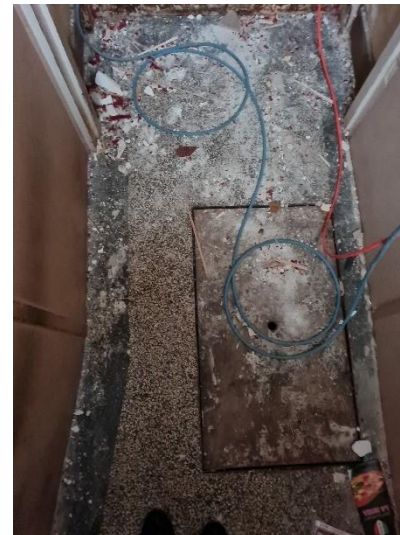
Granito vloer begane grond
