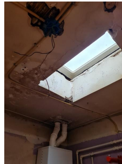
Vernieuwd daklicht. De kooflijsten tussen muur en plafond zijn nog zichtbaar.
