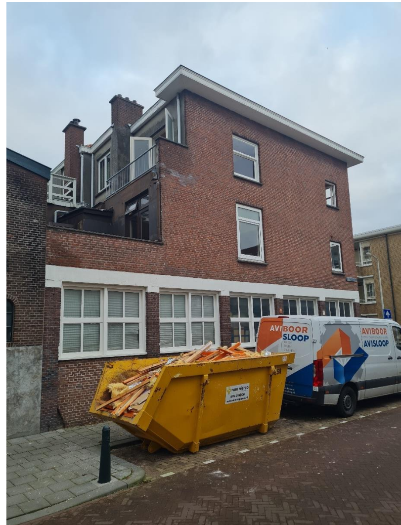
Achtergevel en linkerzijgevel. Met name op het niveau van de begane grond is de linkerzijgevel ingrijpende gewijzigd.
